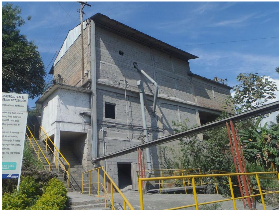
Figura 13. Sección de trituración, Planta CEMEX S.A.
