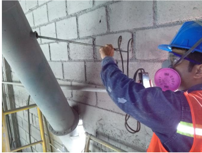
Figura 17. Adaptación previa a la toma de presiones.
