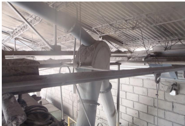
Figura 23. Conducto conectado a codo.
