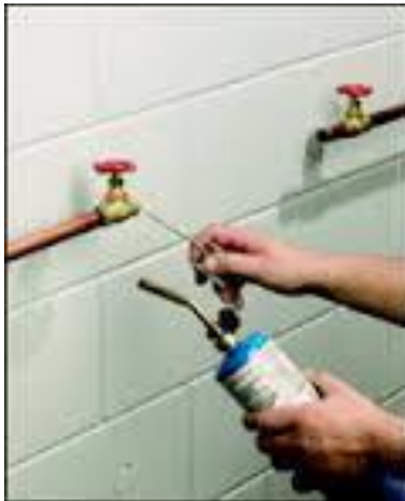
Figura 3. Servicio técnico e Instalación de filtros de agua
