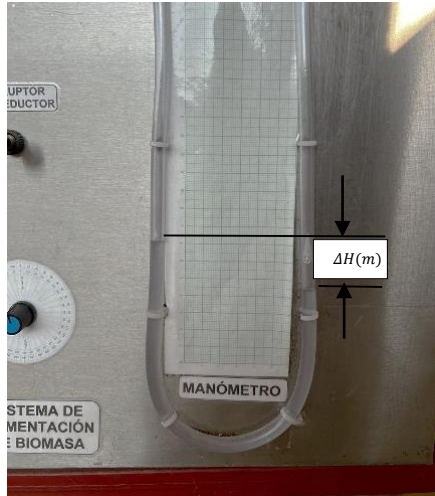
Figura 24. Manómetro analógico de la línea de entrada del aire al quemador ciclónico de biomasa
