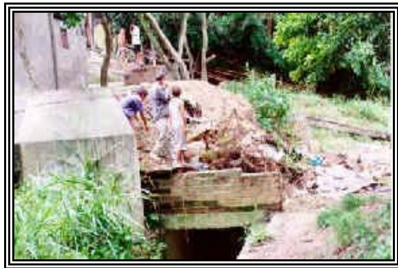
Foto 4. Estructura ubicada en el viaducto La Flora
