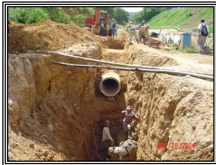
Foto 1. Construcción del interceptor de aguas negras. Quebrada La Iglesia.
