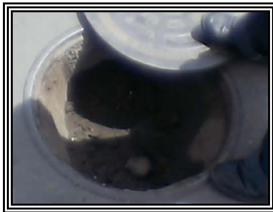
Foto 39. Pozo colmatado estación de servicios Terminal de transportes
