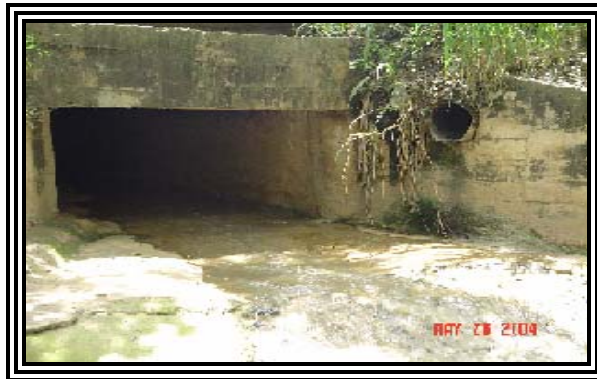
Foto 34. Box culvert en estudio.
