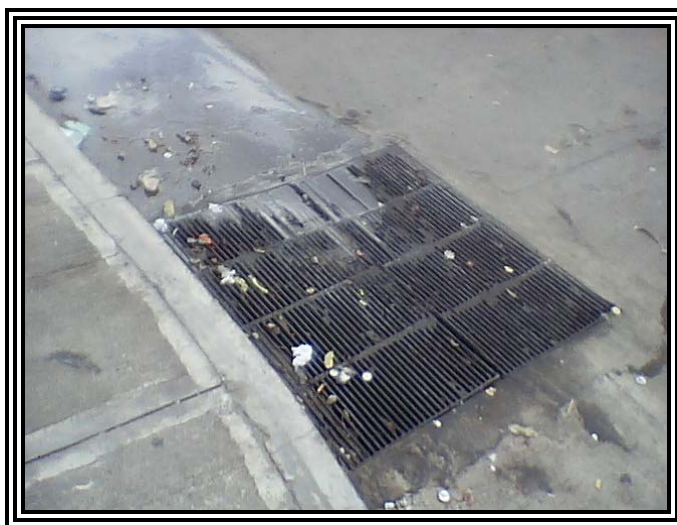
Foto 40. Conexión errada aguas servidas arrojadas al sistema pluvial.
