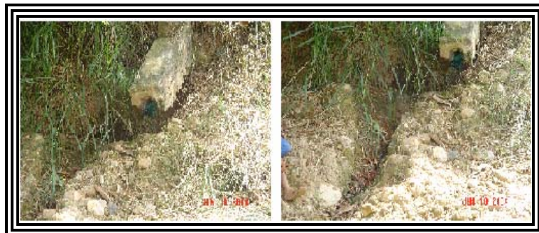
Foto 32. Descargas provenientes de Ibáñez Castilla.
