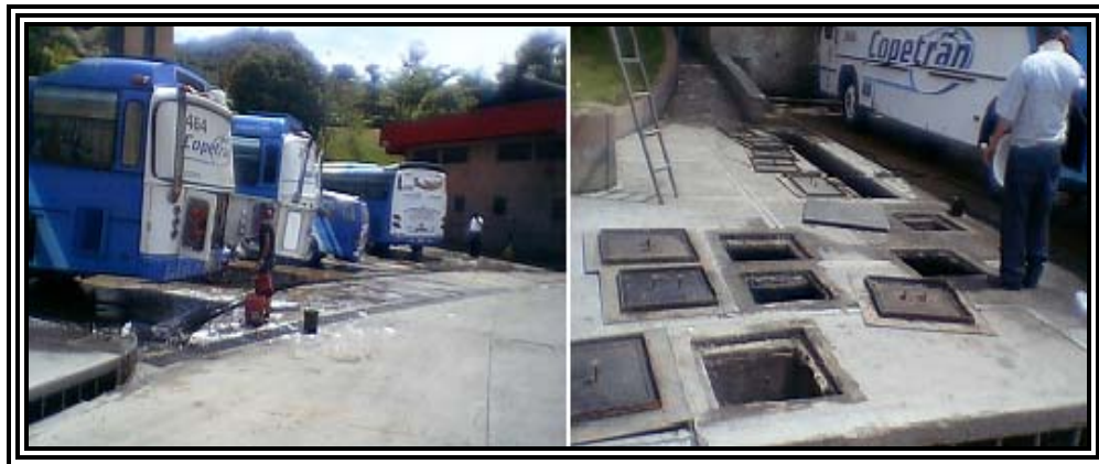
Foto 38. Sistema de tratamiento de aguas estación de servicios del Terminal de transportes.
