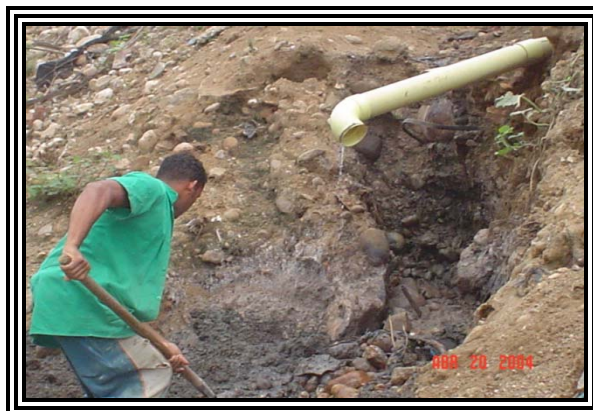
Foto 10. Construcción de caja de inspección en Aceygrades.
