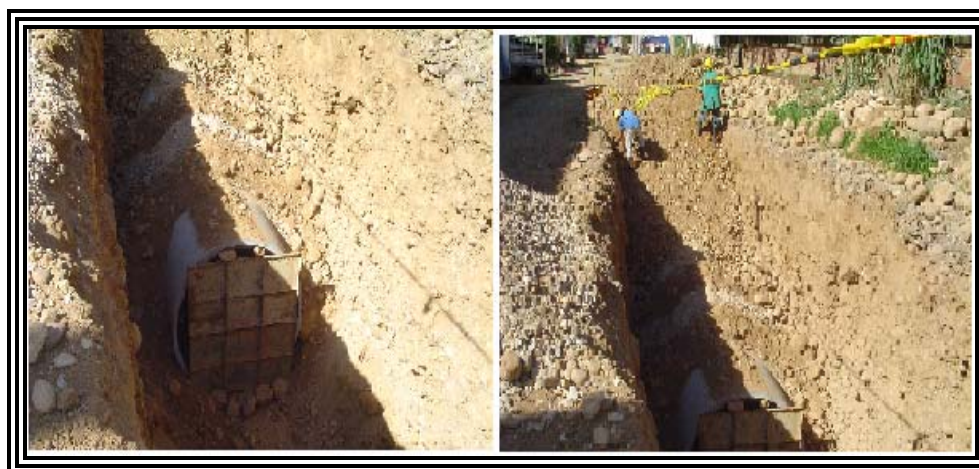
Foto 18. Construcción de colector pluvial sobre la Cra 14. \varnothing = 1500 mm
