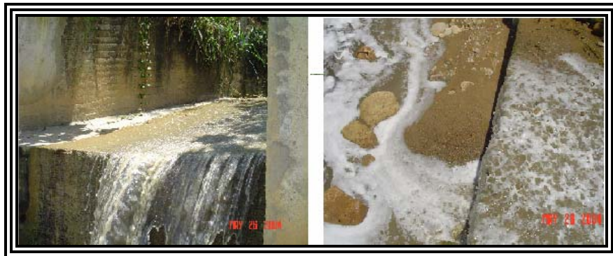
Foto 35. Entrega a la quebrada del box culvert en estudio
