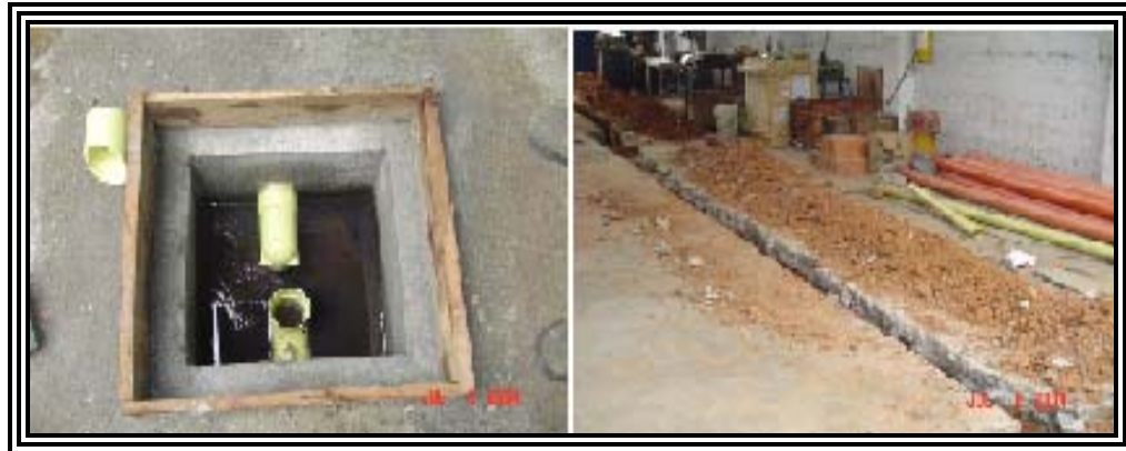
Foto 42. Obras realizadas en COENSA
