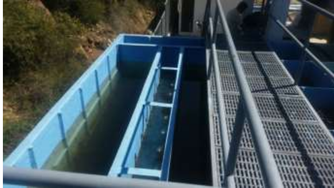
Figura 7. Sedimentador
