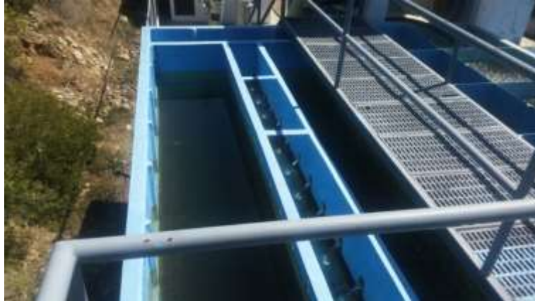
Figura 17. Sedimentador de alta tasa
