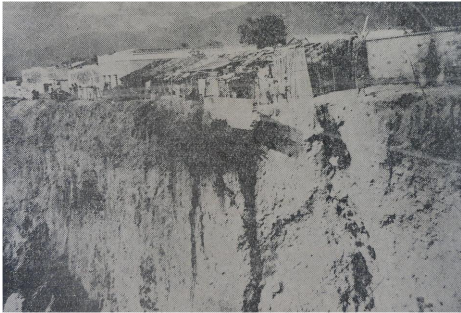
Fotografía No. 21 Vista parcial de la erosión en San Rafael y Norte Bajo.
