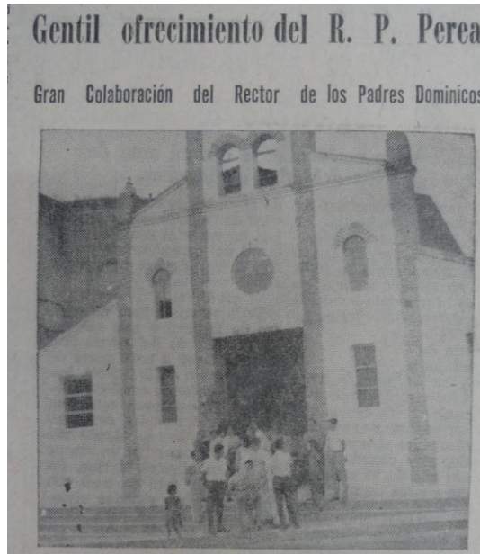
Fotografía No. 29 Fachada del Antiguo Templo de Cristo Rey, 1966.
