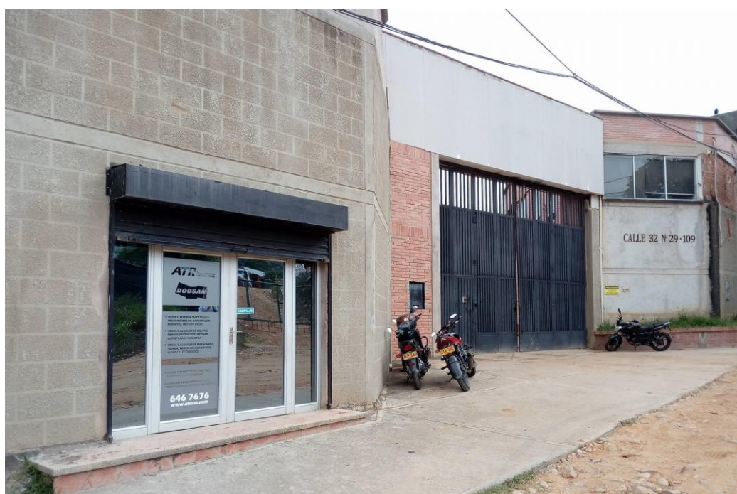
Figura 3. Instalaciones actuales de ATR S.A.S. sede Girón
