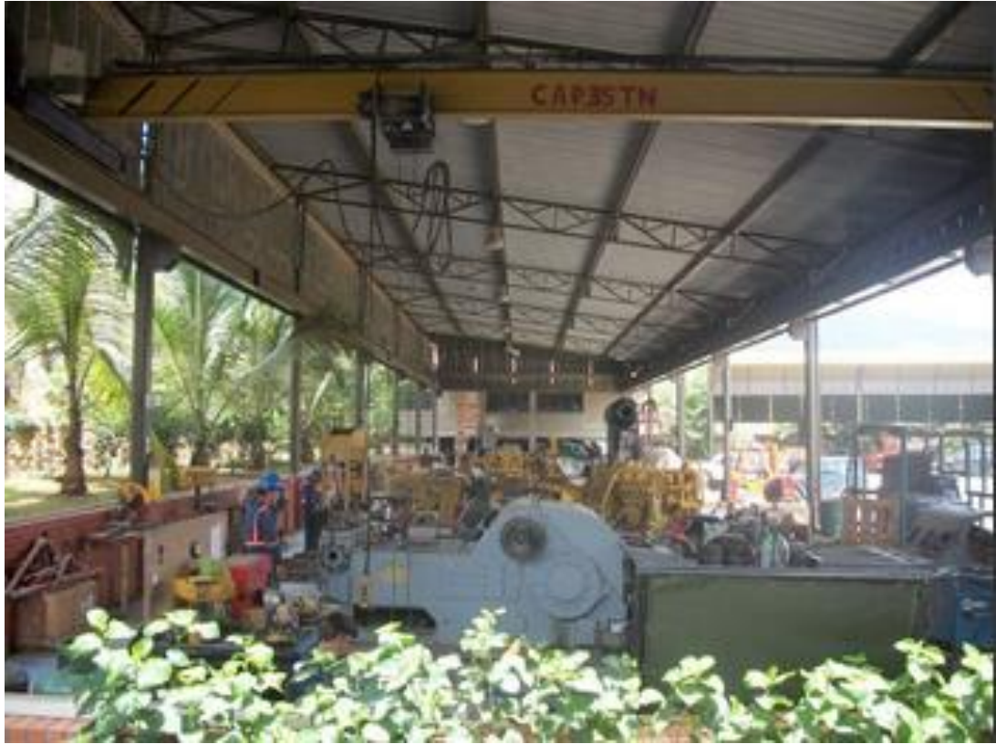
Figura 4. Naves de trabajos con puente grúa y trampa de grasa
