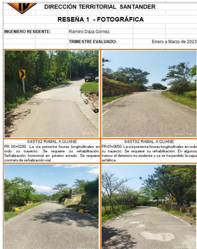
Figura 12. Seguimiento fotográfico de mantenimiento vial.
