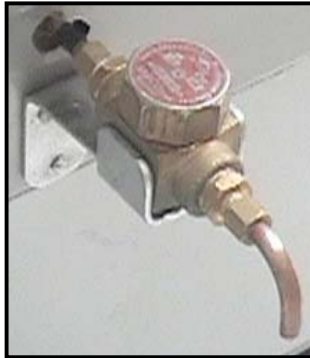
Figura 15. Trampa de vapor Fuente Autores
