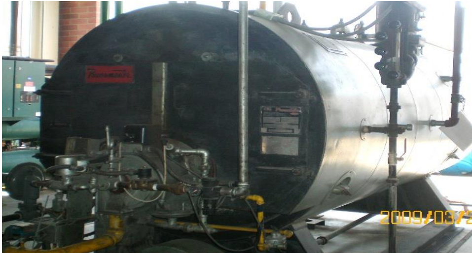
Figura 4. Caldera de Vapor Power Master. 3HL-WB5-70-150
