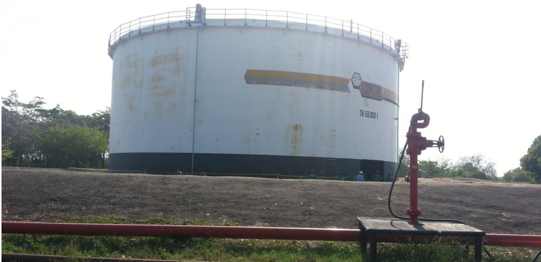
Figura 24. Tanque Chicagua-55000 Bls
