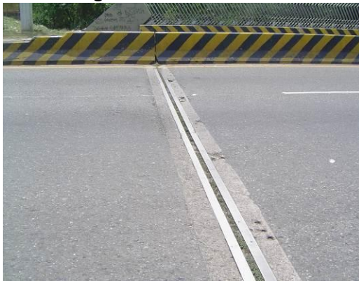
Figura.34 Viaducto La Flora
