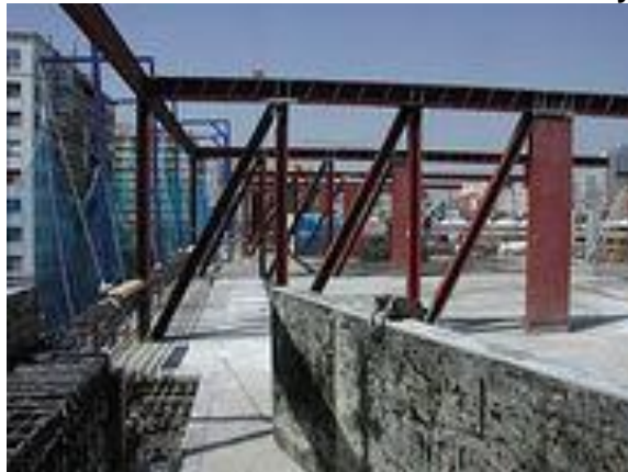
Figura 83 Armado de estructura: estructura metálica y concreto
