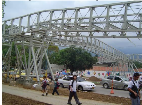
Figura.35 Puente Colegio Inem
