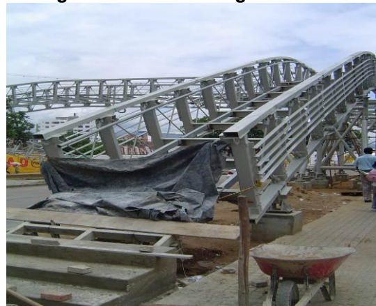
Figura.37 Puente Colegio Inem
