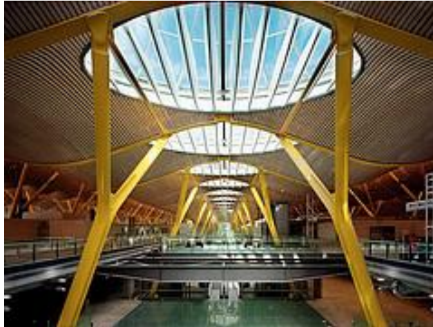
Figura 82 Estructura Combinada Metálica Concreto
