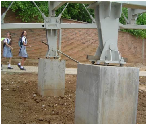
Figura.36 Puente Colegio Inem
