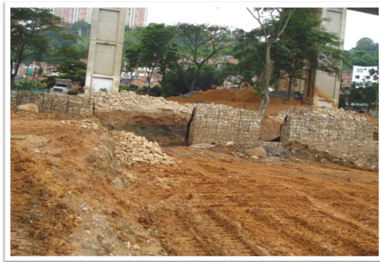
Figura 11. Parque de Deporte Extremo Muros de Contención Gaviones.
