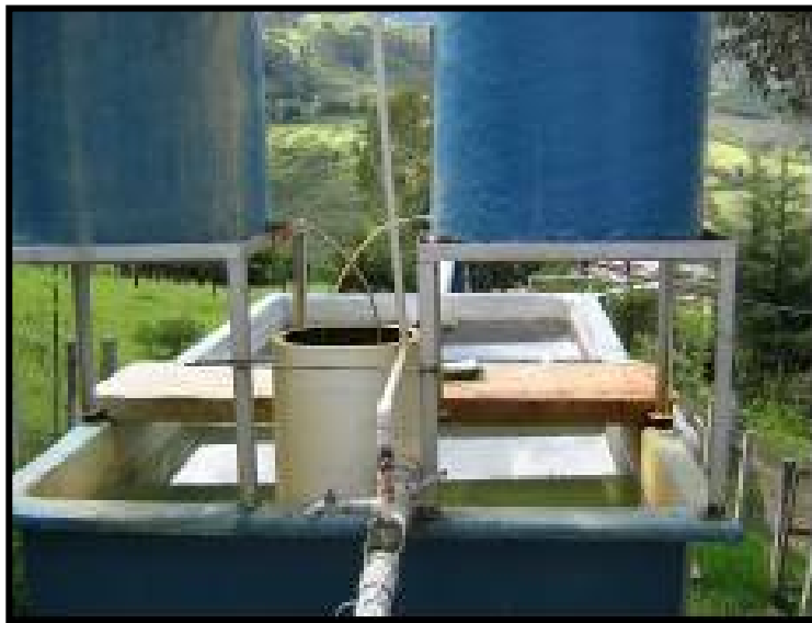
Ilustración 7. Dosificación de reactivos
