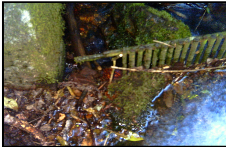
Ilustración 3. . Rejillas de Captación actuales
