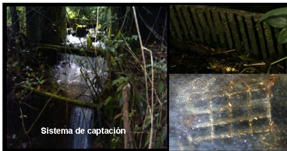
Ilustración 16. Bocatoma municipio de surata
