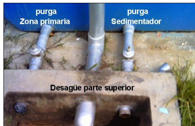
Ilustración 22. Válvulas de purga
