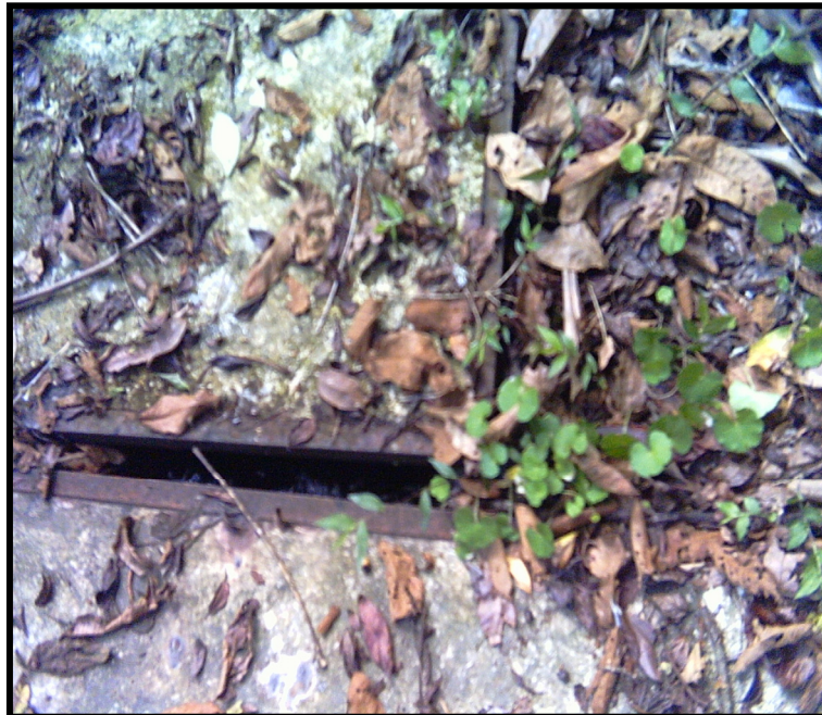
Ilustración 5. Tanque de almacenamiento posterior al desarenador
