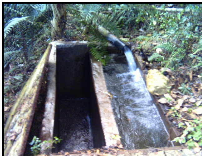
Ilustración 4. Desarenador después de captación
