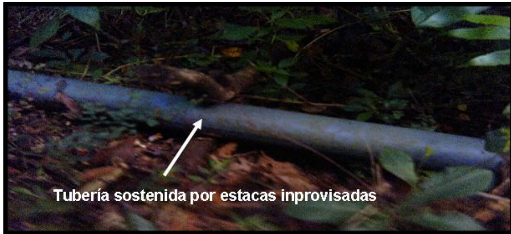
Ilustración 19. Aseguramiento provisional sistema de conducción
