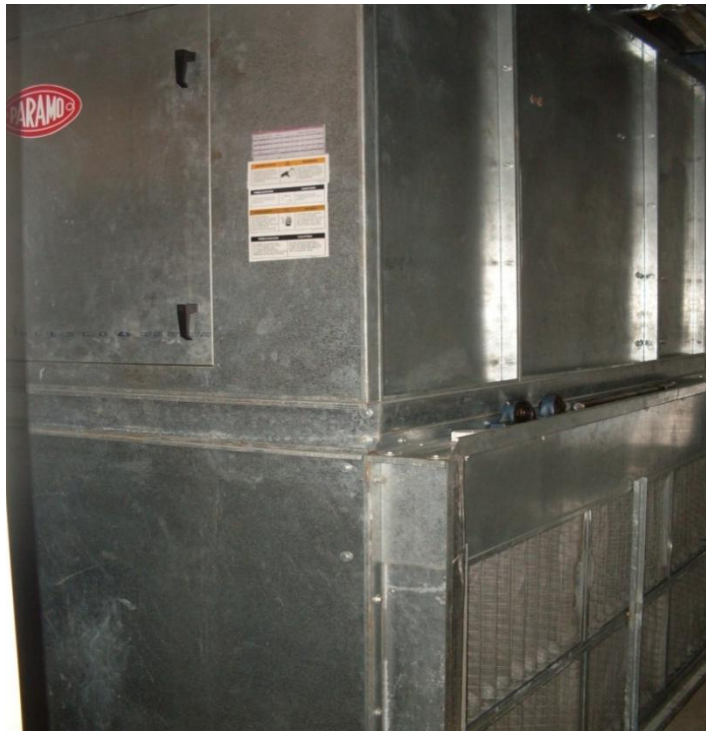
Figura 54: Unidad Manejadora de Aire marca Paramo
