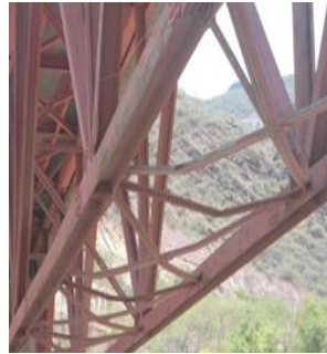
Figura 6. Abolladura.
