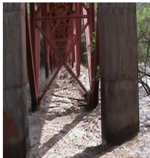
Figura 3. Riostras del puente. Figura 4. Elemento inferior.
