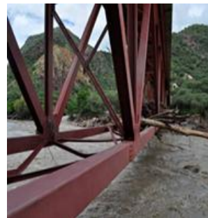
Figura 3. Riostras del puente. Figura 4. Elemento inferior.
