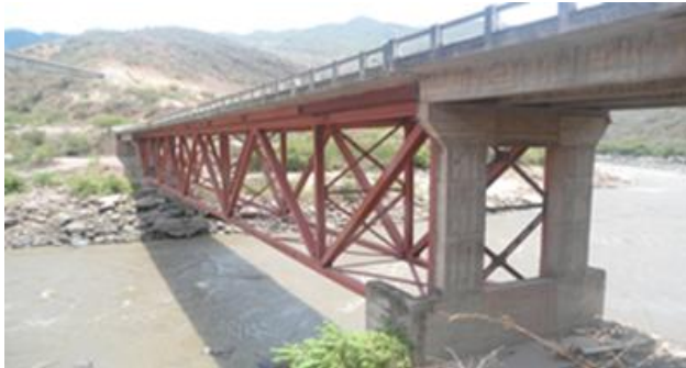
Figura 2. Vista Lateral Puente Guillermo Gómez Ortiz.
