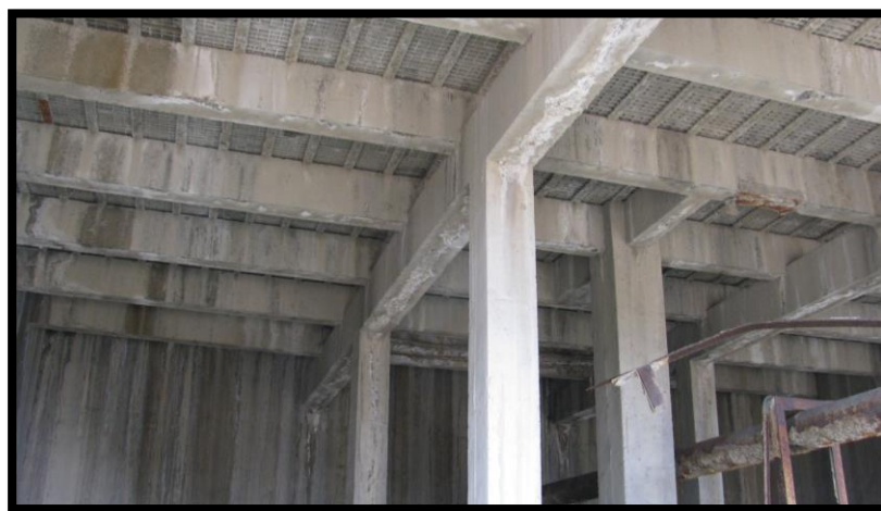
Figura 33. Fotografía vista del interior de la celda central del costado occidental (Fuente: el autor).
