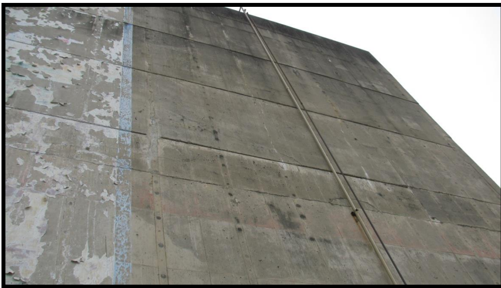
Figura 62. Fotografía vista de la parte superior del muro costado norte (Fuente: el autor).
