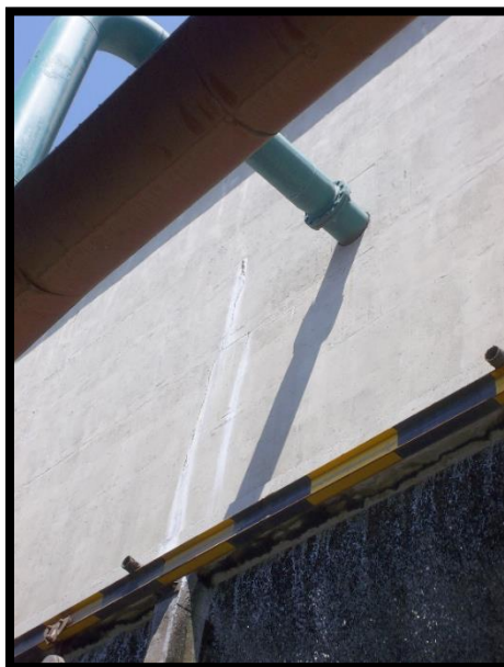
Figura 30. Fotografía fisuras costado occidental (Fuente: el autor).
