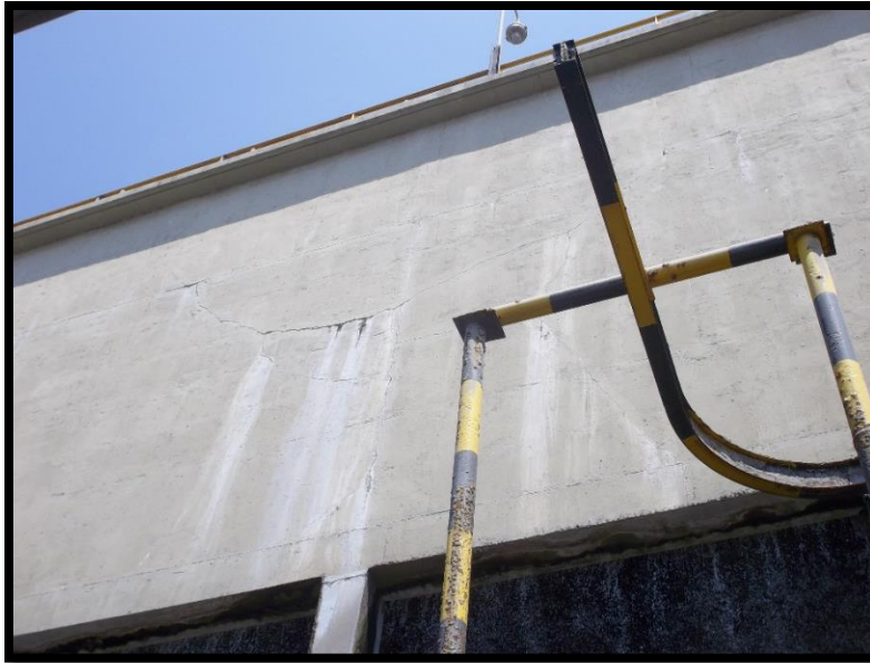
Figura 30. Fotografía fisuras costado occidental (Fuente: el autor).
