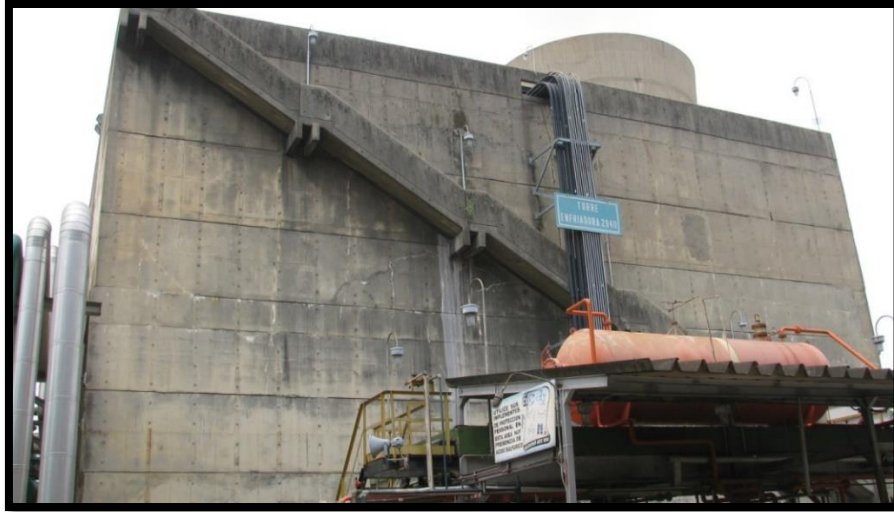
Figura 59. Fotografía vista del costado sur (Fuente: el autor).
