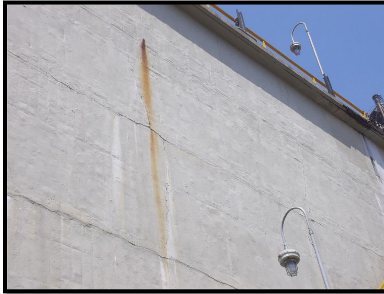
Figura 36. Fotografía del muro del costado sur actualmente (Fuente: el autor).
