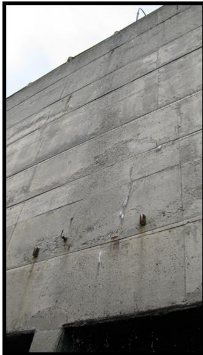
Figura 8. Fotografía detalle del muro superior del costado oriental (Fuente: el autor).
