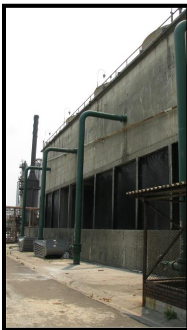
Figura 27. Fotografía vista general del costado oriental de la TE-850 (Fuente: el autor).
