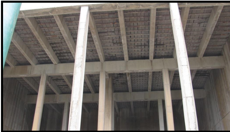
Figura 60. Fotografía vista interior de una de las celdas del costado oriental (Fuente: el autor).
