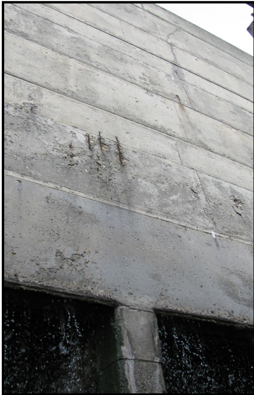
Figura 15. Fotografía detalle muro superior y viga sobre columnas en el costado occidental (Fuente: el autor).
