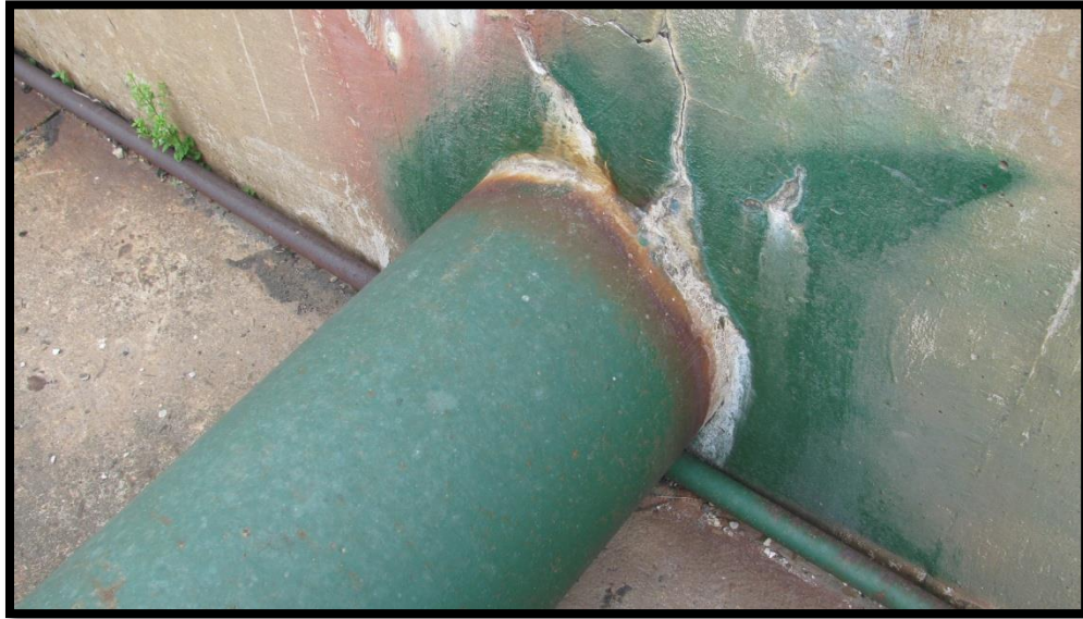
Figura 63. Fotografía detalle de las tuberías pasantes en el tanque (Fuente: el autor).
