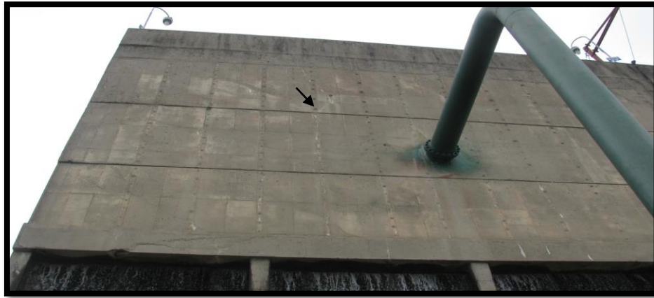
Figura 48. Fotografía vista general del costado oriental de la TE-2940 (Fuente: el autor).
