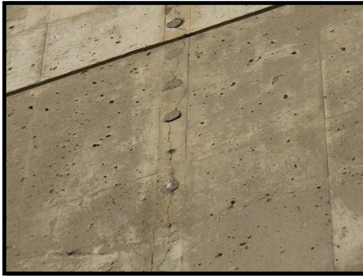
Figura 50. Fotografía detalle de la situación descrita con los pasantes de fijación de la formaleta (Fuente: el autor).
