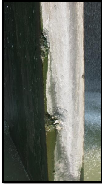
Figura 42. Fotografía columna con lesiones en el costado occidental de la TE-850 (Fuente: el autor).
