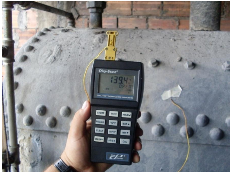
Figura 21. Medición de temperatura del las paredes del hogar
