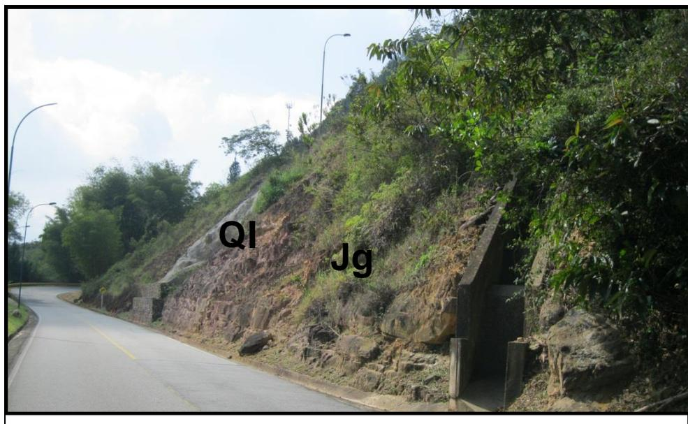
**Figura 18** Vista general de los taludes conformados por depósitos coluviales sobre rocas y suelos residuales de la formación Girón.
