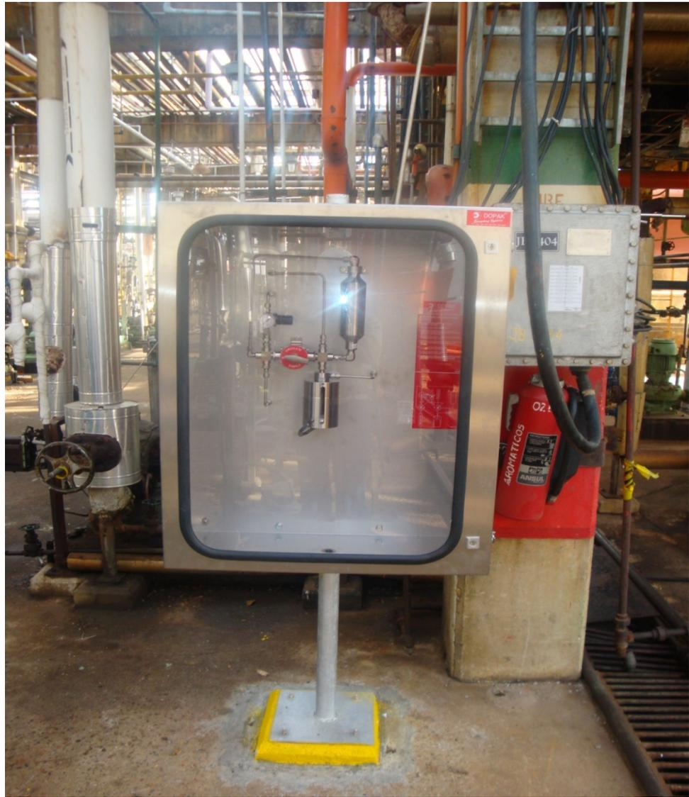
Figura 3: Dispositivo toma-muestra.
