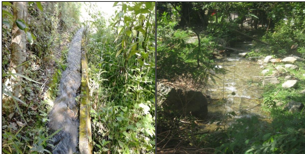
Figura 29. Canales de Captación rudimentarias para riegos de cultivos Agrícolas en La parte Baja de la Microcuenca Quebrada.
