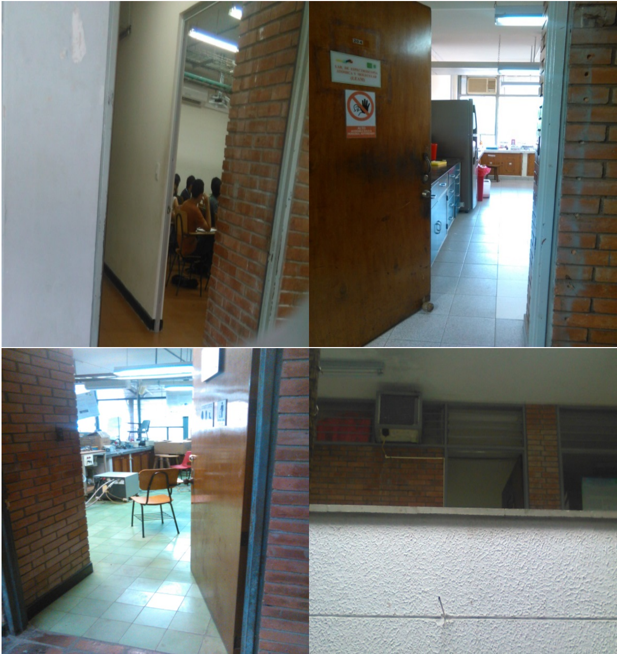
Figura 5.8: Uso inadecuado aire acondicionado
