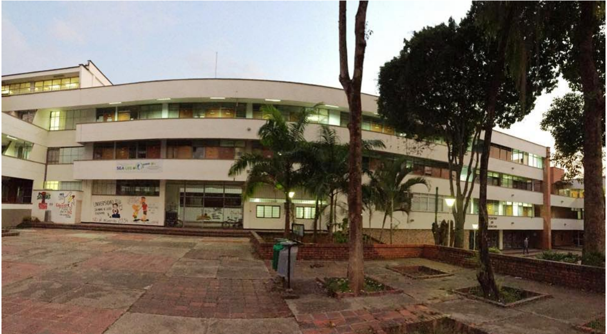
Figura 1.3: Vista exterior del edificio Laboratorio Livianos
