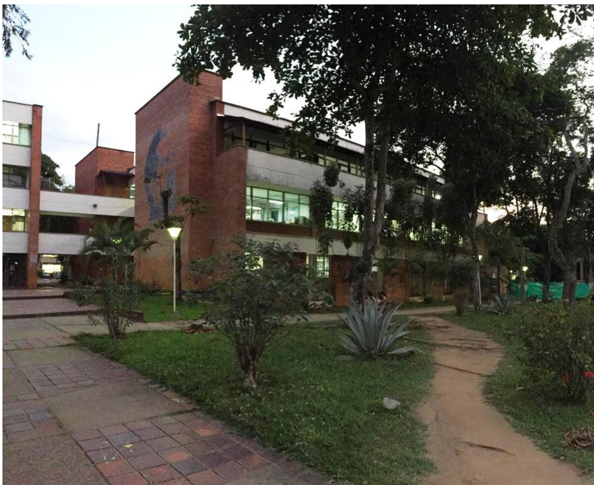
Figura 1.4: Vista exterior edificio Posgrados
