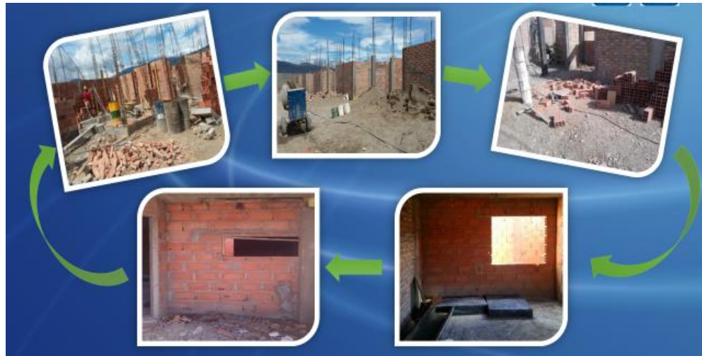
Figura 22. El antes sin modulaciones de muros
