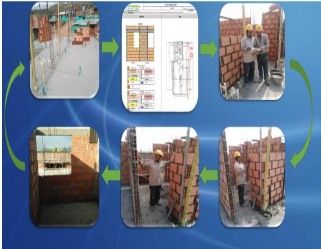
Figura 26. Modulación de muro su proceso de construcción
