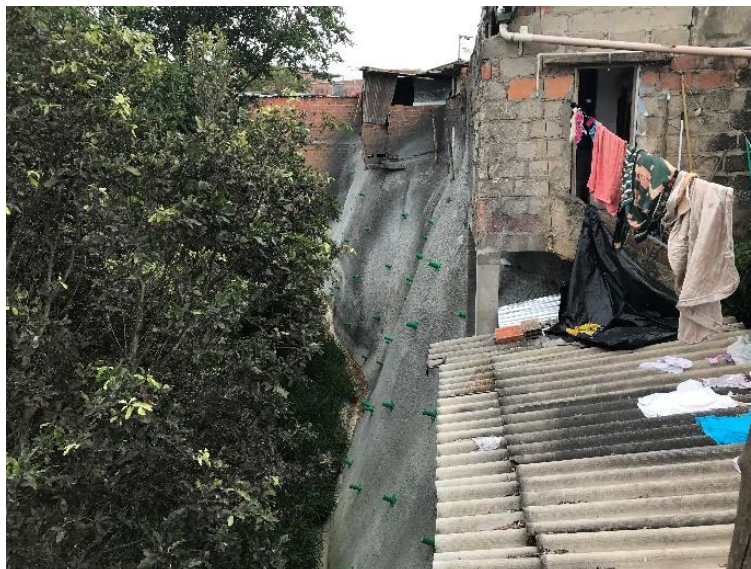
Figura 9. Estructura anclada situada en la parte sur del barrio Don Bosco, una de las obras de mitigación planteadas por la CDMB.
