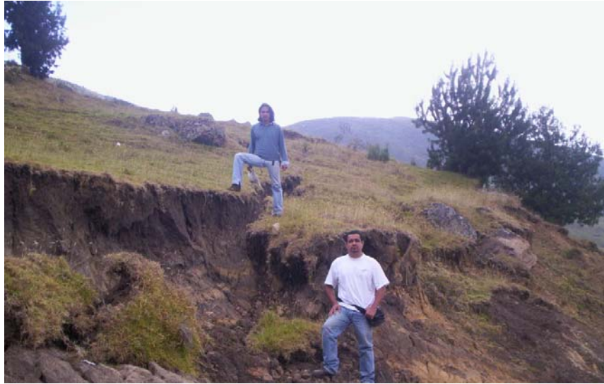
Figura 37, Deslizamiento zona norte UNIPAMPLONA.
