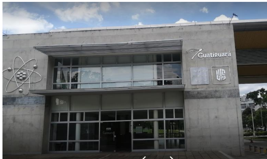
Figura 20. Fotografía entrada principal Sede Guatiguara
