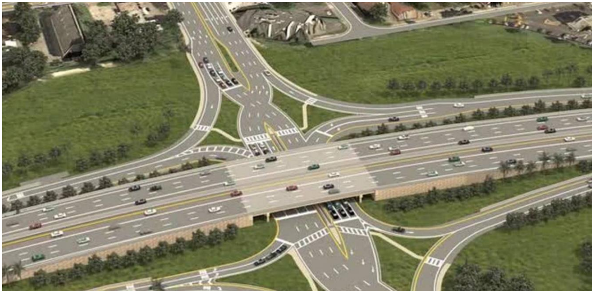
Figura 10. Intersección a desnivel tipo diamante divergente. Tomado de Tocograferos. Retrieved from https://www.miamiherald.com/news/article138156553.html
