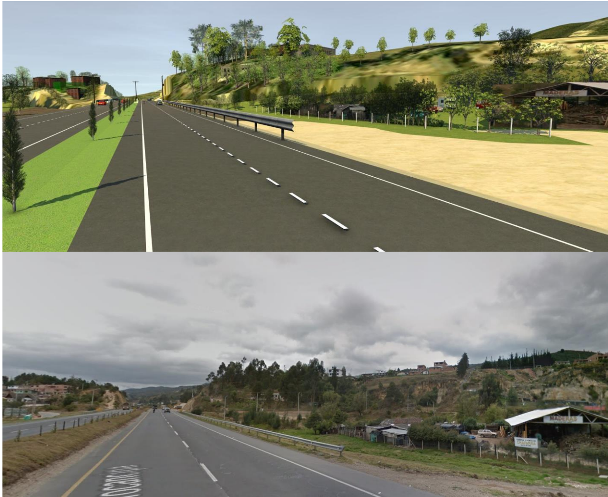
Figura 115. Modelo BIM de condiciones existentes vs fotografía 2 del sitio de la intersección vial a desnivel tipo trébol.
