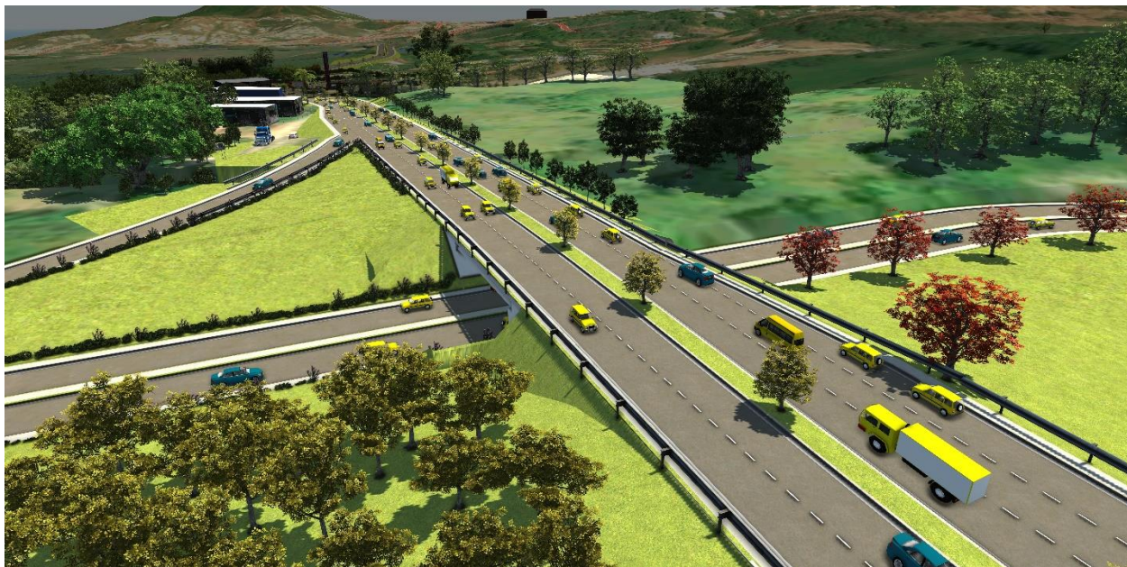
Figura 98. Tramo recto de la calzada principal para la disposición de la intersección tipo trompeta.
