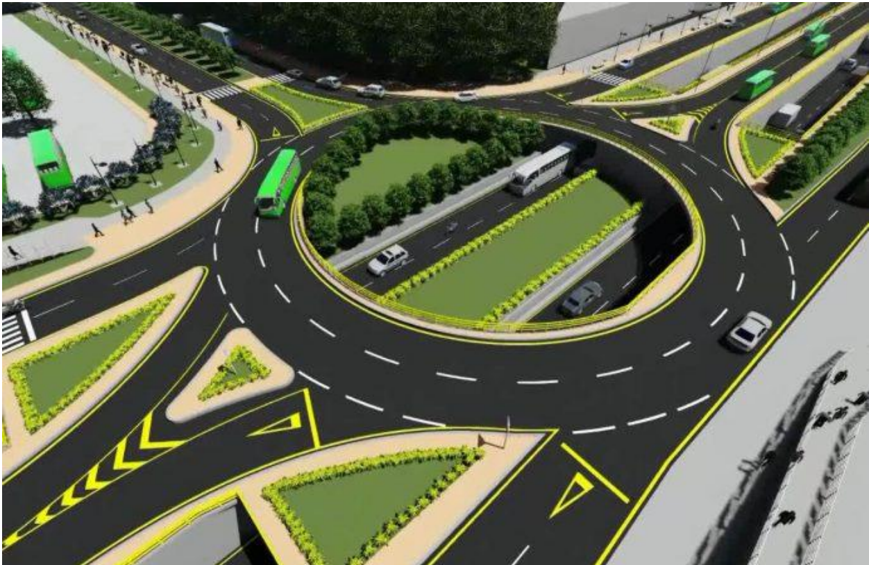
Figura 9. Intersección a desnivel tipo glorieta. Tomado de Metrolinea. Retrieved from https://melodiaenlinea.com/adjudicada-licitacion-del-intercambiador-guatiguara/
