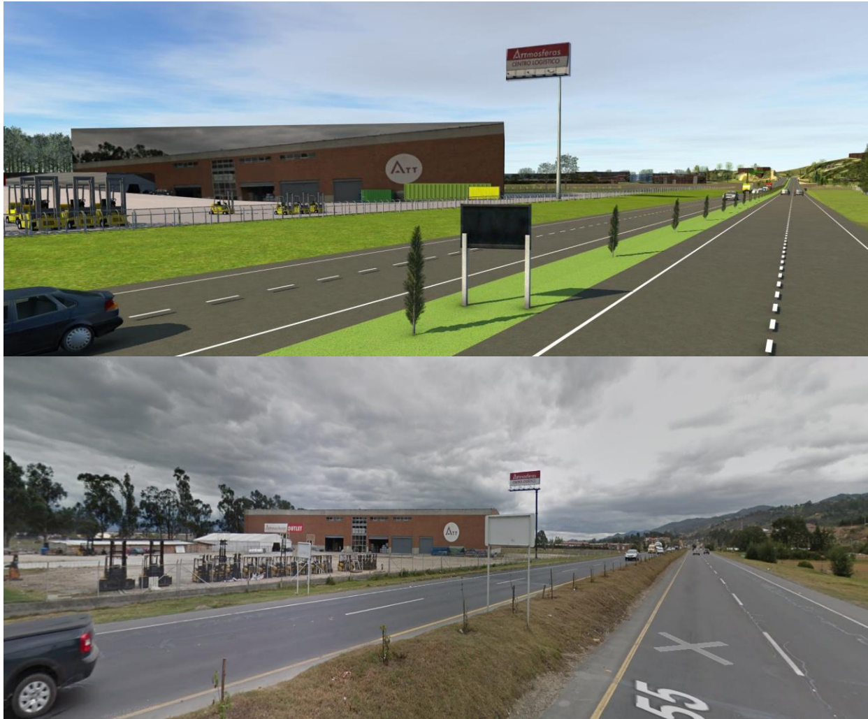
Figura 114. Modelo BIM de condiciones existentes vs fotografía 2 del sitio de la intersección vial a desnivel tipo trébol.
