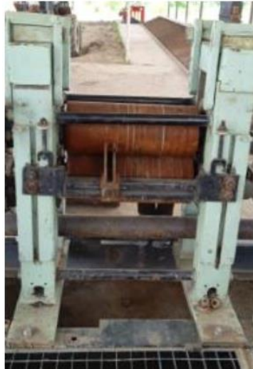
Figura 7. Torre de preparado del tren de laminación
