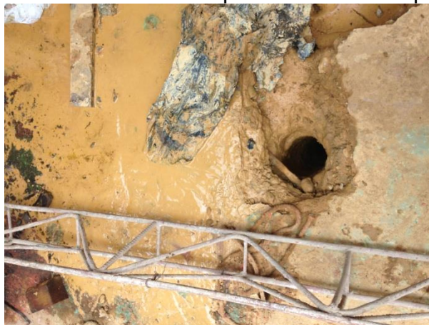
Fotografía 9. Diámetro de la perforación de 2.5 pulgadas.
