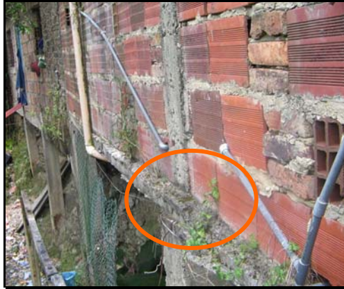
Problemas en uniones viga-columna
