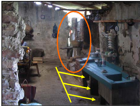
Ejemplos de estructuras con desplazamientos
