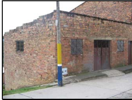
Vivienda en Jesús Maria, Santander con sistema de muros no reforzados.
