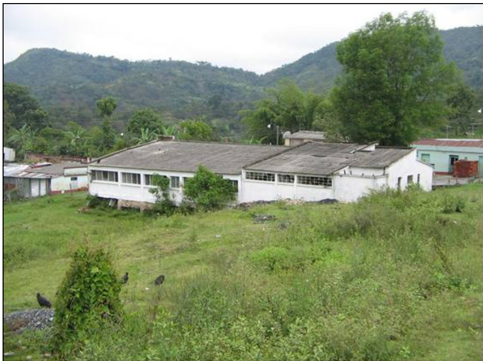
Figura 27. Vista general del hospital antiguo que se ubica sobre un movimiento de tipo reptación Fuente: Investigación de los Autores, 2005.
