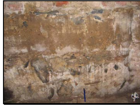
Ejemplos de humedades en muros
