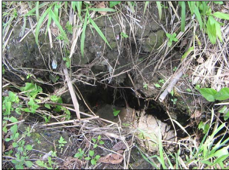
Figura 73. Sector N, se observa la formación de grietas en el terreno por donde transitan las aguas servidas sin control antes de llegar al Chorro Tequendama.
