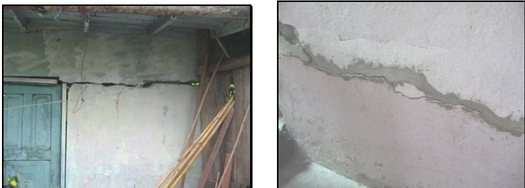
Ejemplos de falla por flexión
