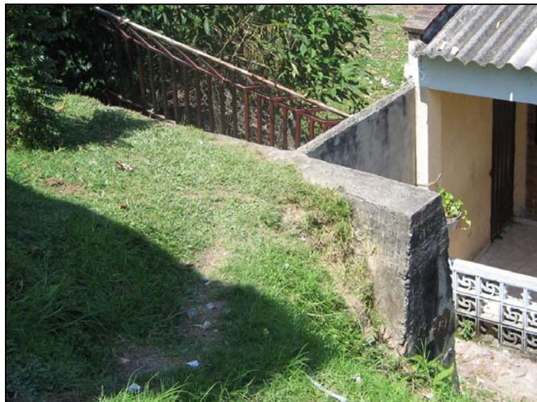
Figura 65. Muro de Contención Colegio Lorenzo de Salazar Fuente: Investigación de los autores, 2005.
