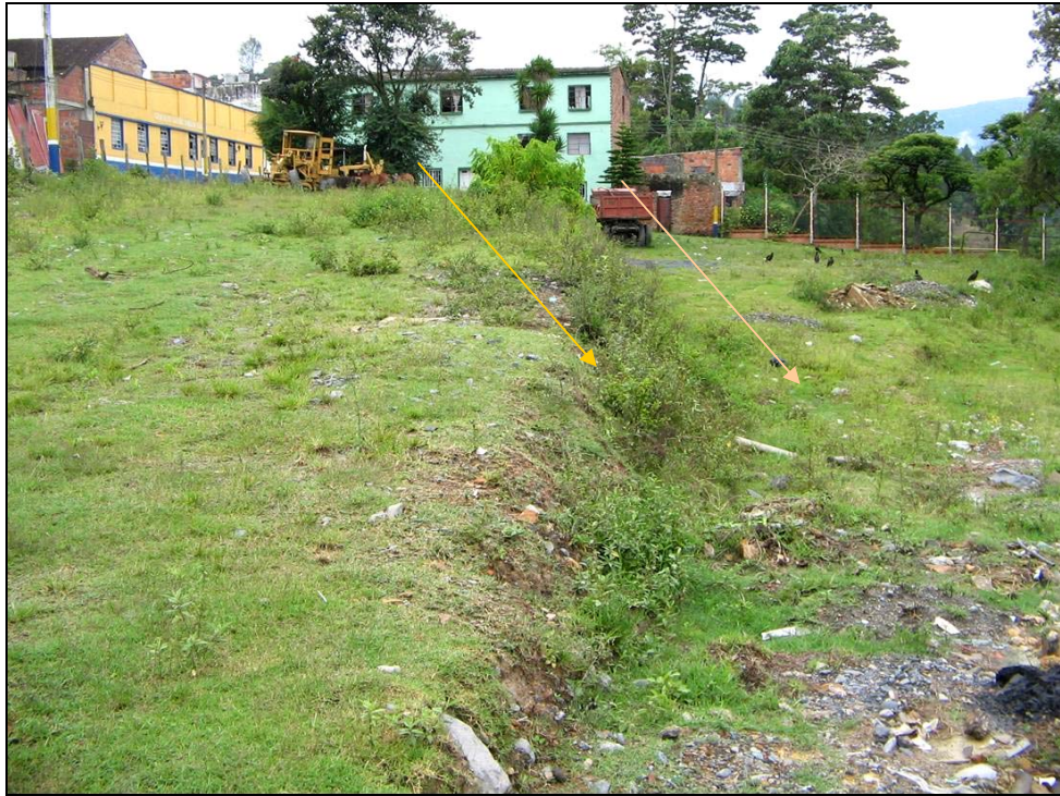
Figura 28. Vista donde se muestra los elementos geomorfológicos presentes en el cuerpo del movimiento. Obsérvese la disposición en escalones debido a la intervención antrópica. Las flechas en naranja indican las zonas de empozamiento que se encontraron en el sitio.
