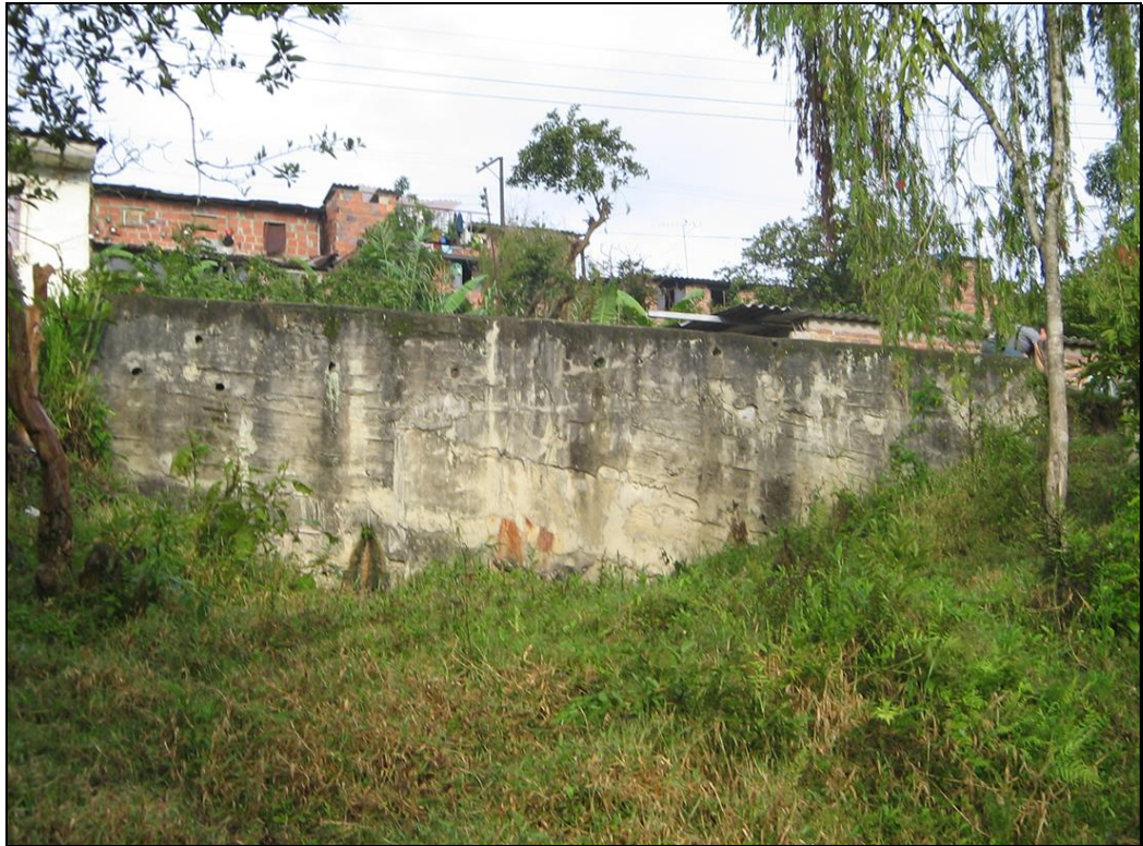
Figura 24. Muro de Contención localizado en la Calle de las Trampas
