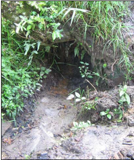
Figura 77. Aguas de fuentes naturales sin control. Sector Casa de la Cultura Fuente: Investigación de los autores, 2005
