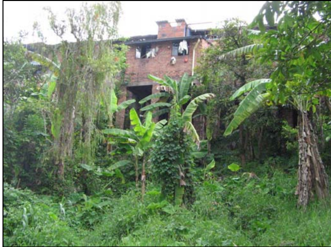
Figura 40. Sector de muestra 5 ubicada en el Sector H en la Calle de Las Trampas
