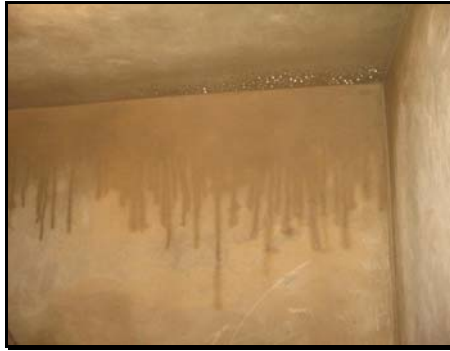
Ejemplos de humedades en muros
