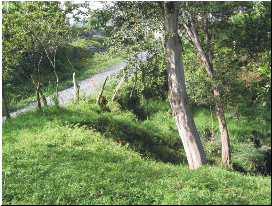
Figura 33. Movimiento de remoción en masa presente en la salida a Florián. Obsérvese que se encuentran sus flancos y su corona bien definidos. La cerca se encuentra afectada indicando que su actividad.
