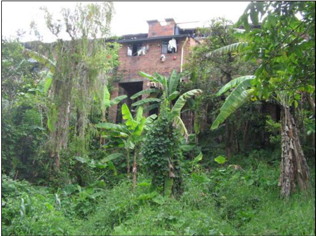
Figura 25. Vista general de la ubicación del movimiento en el sector H.
