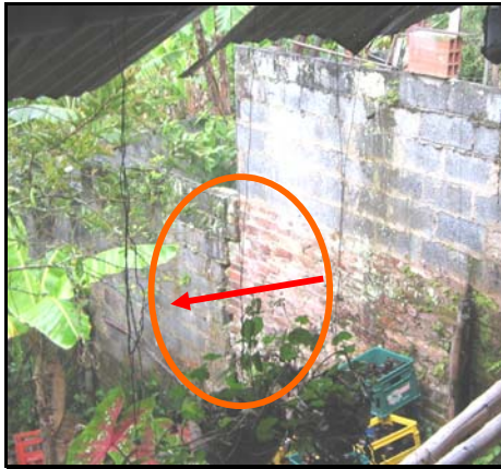
Ejemplos de estructuras con desplazamientos
