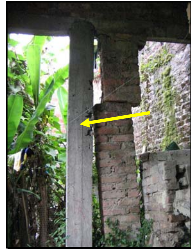
Ejemplos de estructuras con desplazamientos
