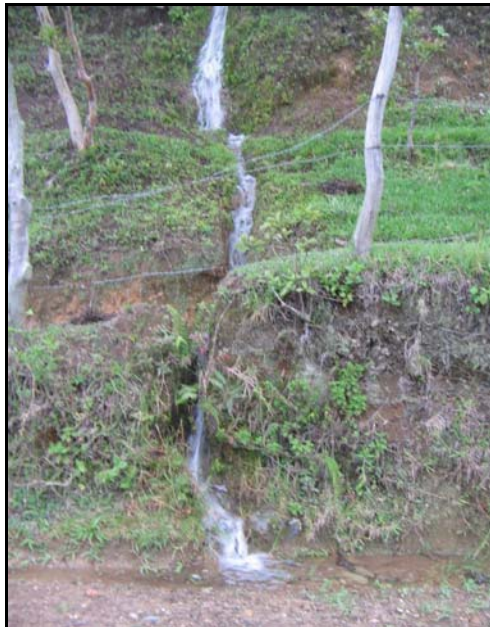
Figura 78. Aguas de fuentes naturales sin control. En la salida vía a Sucre. Fuente: Investigación de los autores, 2005
