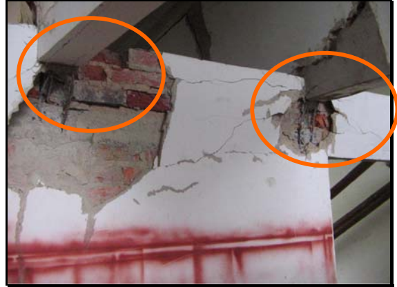
Problemas en uniones viga-columna
