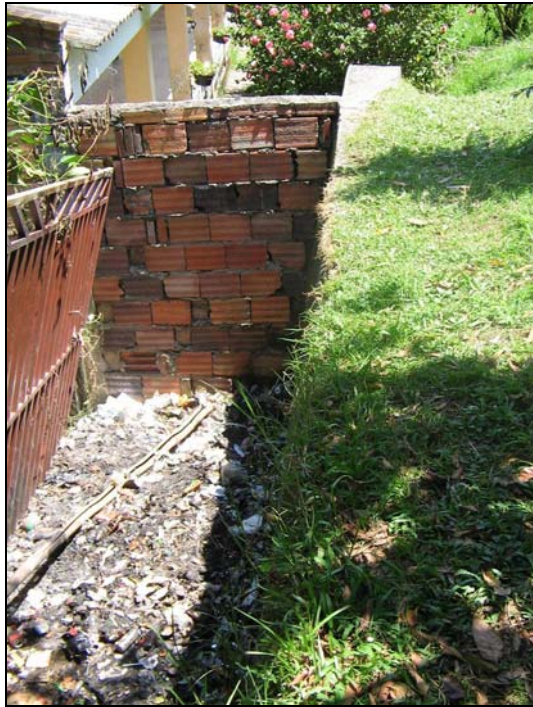
Figura 64. Muro de Contención Colegio Lorenzo de Salazar Fuente: Investigación de los autores, 2005.
