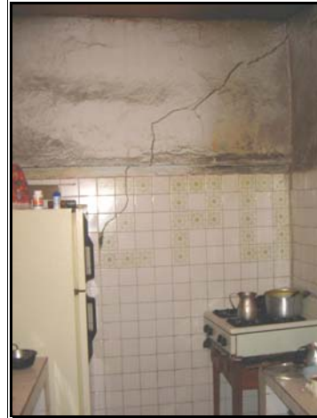
Ejemplos de falla por cortante
