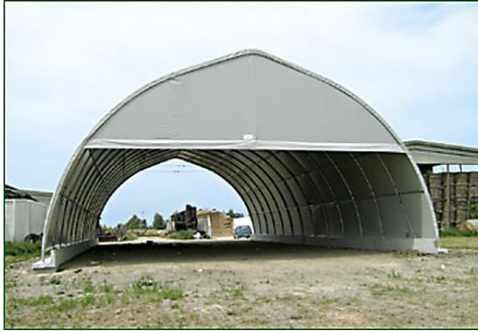
Figura 30. Cubierta con lona de PVC.
