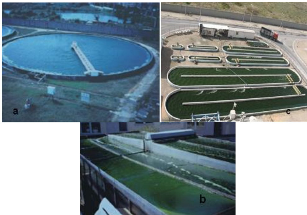
Figura 1. Fotografías de diseños de tanques abiertos (a) Tanque circular con brazo de rotación en Australia occidental, cultivo Dunaliella salina , (b) Tanque circular con agitación en República Checa, cultivo Scenedesmus , (c) Tanque tipo pista en Taipei, cultivo Chlorella . Fuente: MOHEIMANI, 2005
