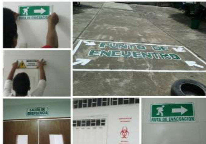
Figura 12. Señalización Ruta de Evacuación y Riesgos.
