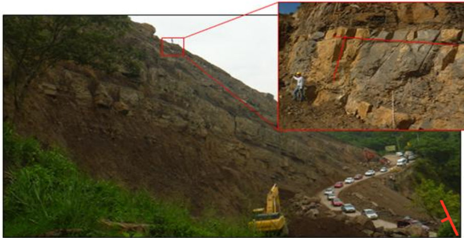
Figura 19. Grado de fracturamiento de la Formación Tablazo.
