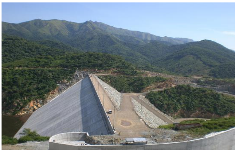
Ilustración 5. Fotografía superior pantalla concreto del embalse Bucaramanga Fuente: blog.structuralia
