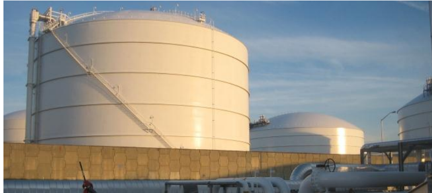
Figura 2. Tanque almacenador de GNL
