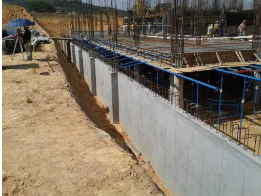
Figura 9. Concreto Muro de Contención
