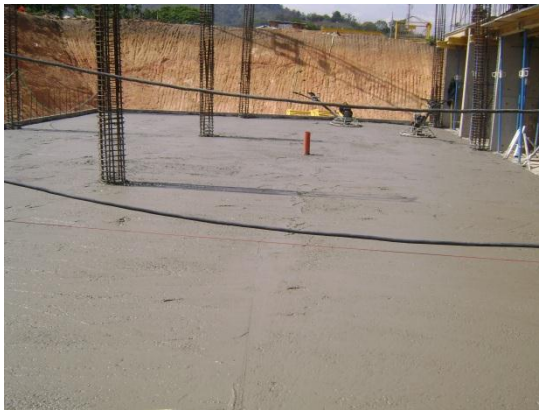
Figura 10. Concreto placa parqueadero
