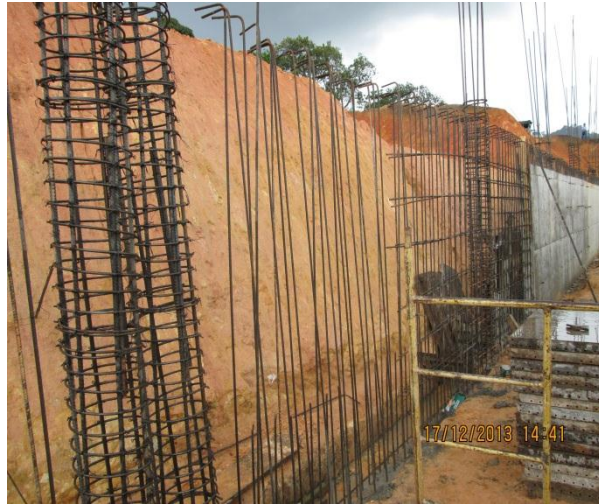
Figura 13. Acero Muro de contención
