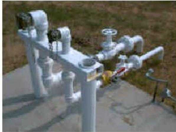
Figura 3. Estación de descarga de camiones.
