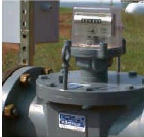
Figura 36. Medidores de flujo y Computadoras de flujo.
