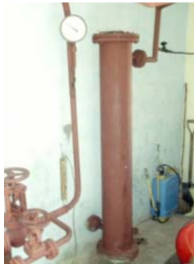
Figura 41. Columna de Absorción de H 2 S.
