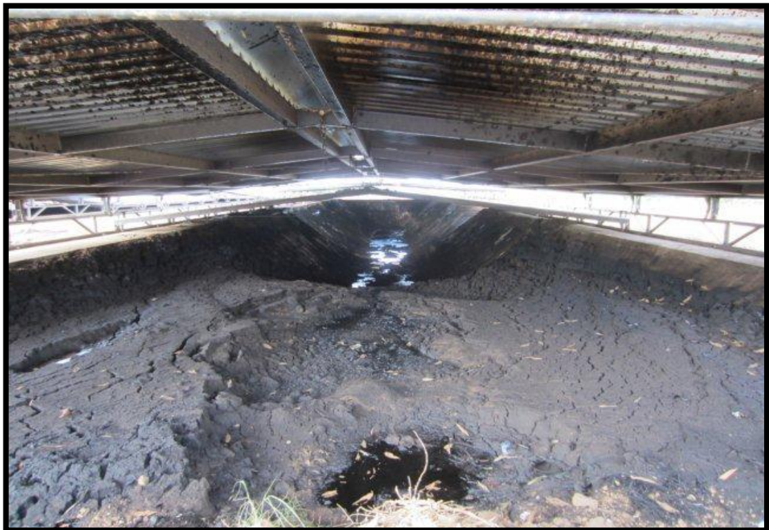
Imagen 3. Borras acumuladas después de la limpieza de tanques en un campo de producción
