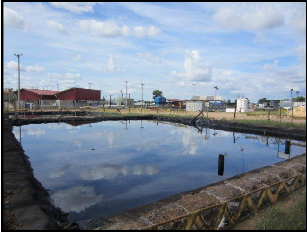
Imagen 10. Borras acumuladas en una fosa de almacenamiento de un campo de producción
