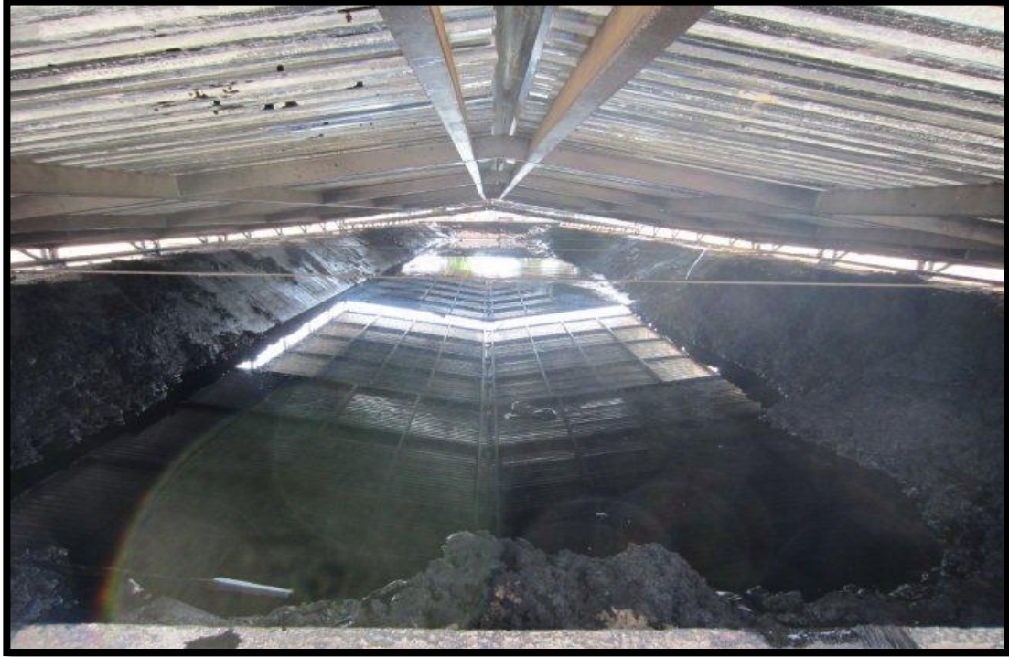
Imagen 8. Lechos de secado de un campo de producción de hidrocarburos
