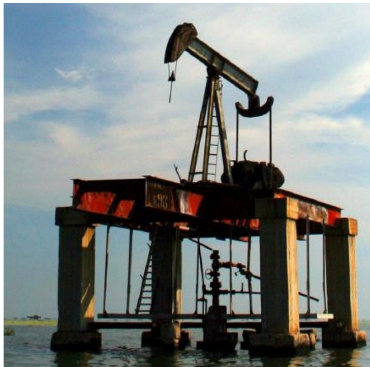
Figura 6. Instalación costa afuera de unidad BMC
