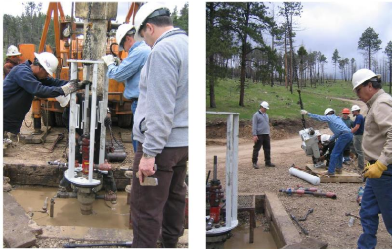
Figura 17. Instalación de base sobre casing para unidad LRP ®
