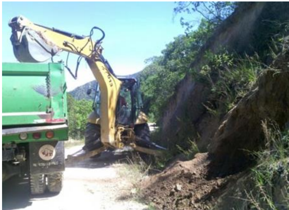
Figura 12. Limpieza de escombros, perfilado del talud y mantenimiento rutinario en Cepita – pescadito (3km). Fuente: Autor
