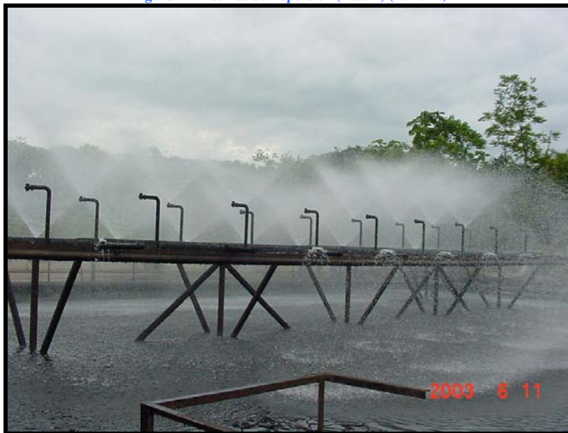
Figura 22. Piscinas de Aspersión (Paso 1) (E. R. A.)
