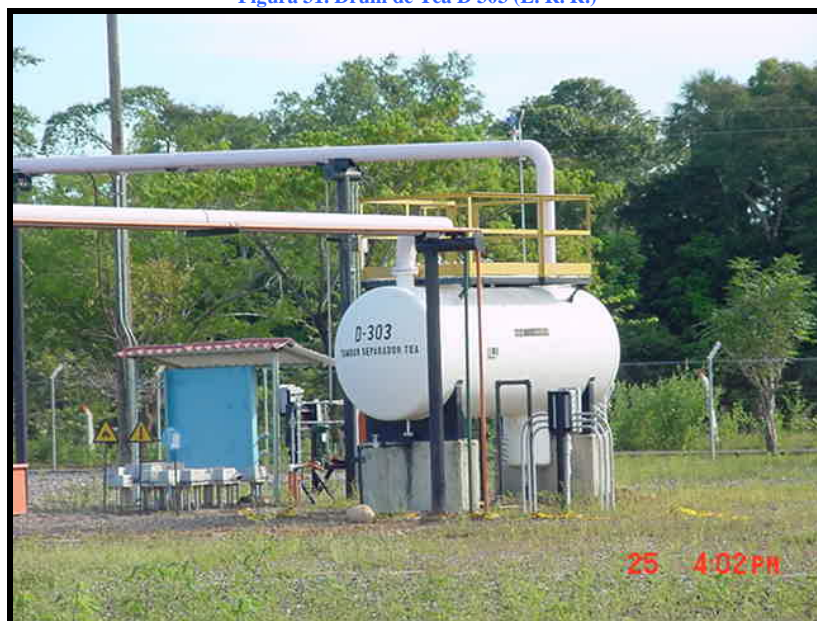
Figura 31. Drum de Tea D 303 (E. R. R.)
