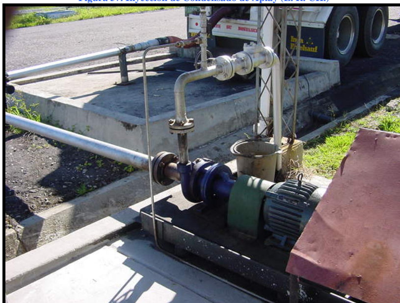
Figura 57. Inyección de Condensado de Apiay (E. R. CH.)
