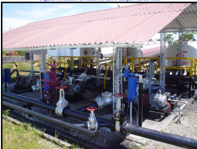
Figura 40. Recibo de crudo de carro tanques (E. R. CH.)
