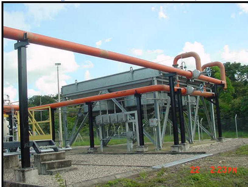
Figura 7. Sistema de Enfriamiento del Gas (E. R. A.)
