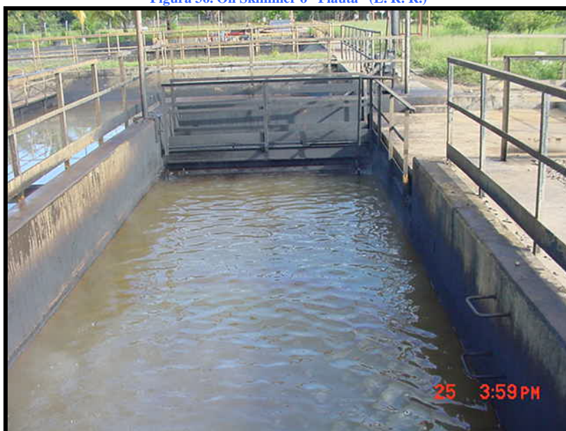
Figura 36. Oil Skimmer o “Flauta” (E. R. R.)
