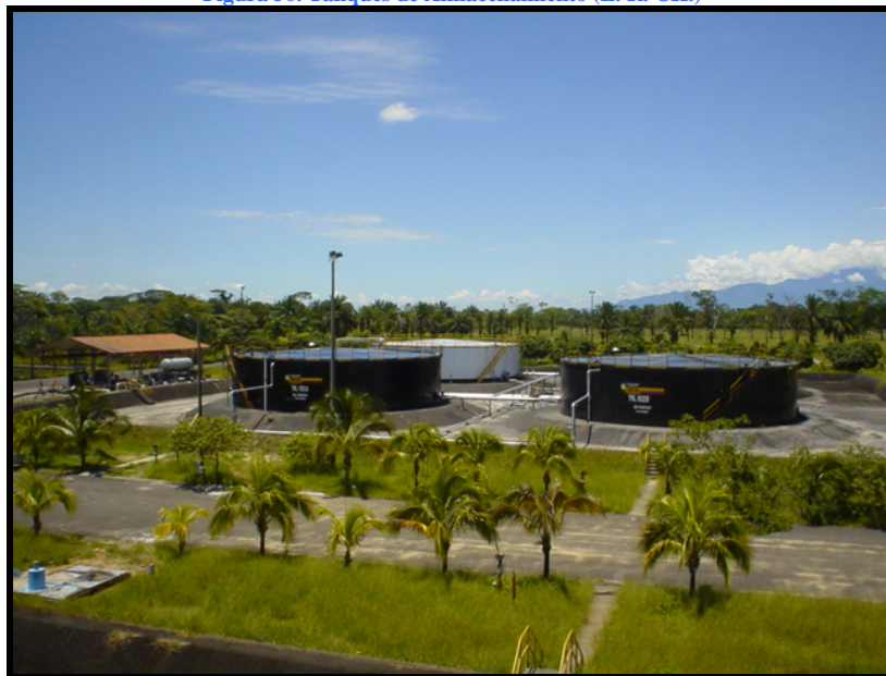
Figura 56. Tanques de Almacenamiento (E. R. CH.)
