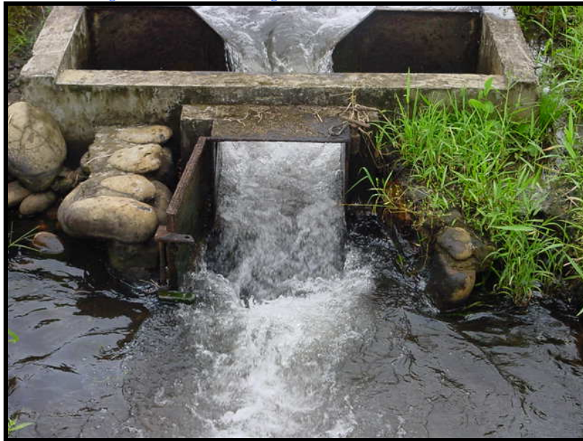
Figura 55. Vertimiento de agua en el Caño Laureles (E. R. CH.)
