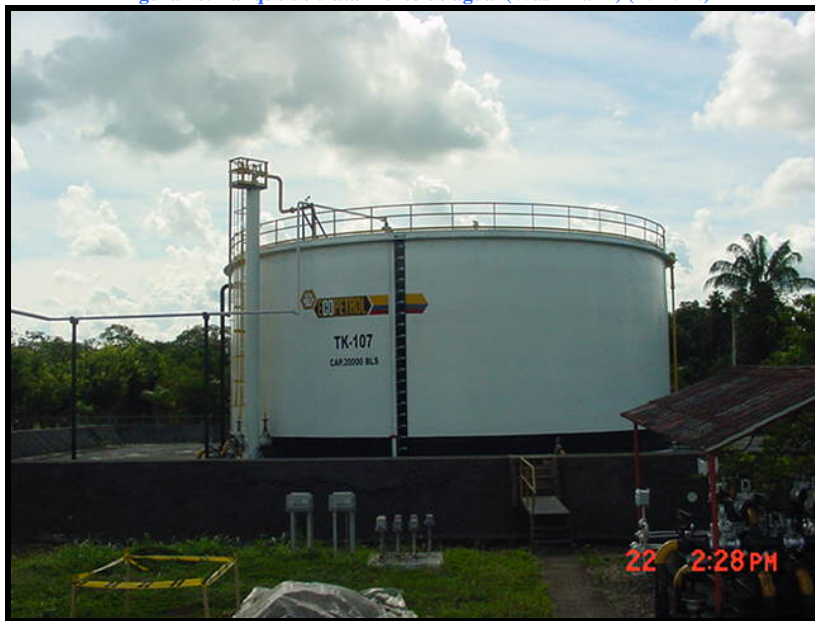
Figura 18. Tanque de tratamiento de agua (Wash Tank) (E. R. A.)
