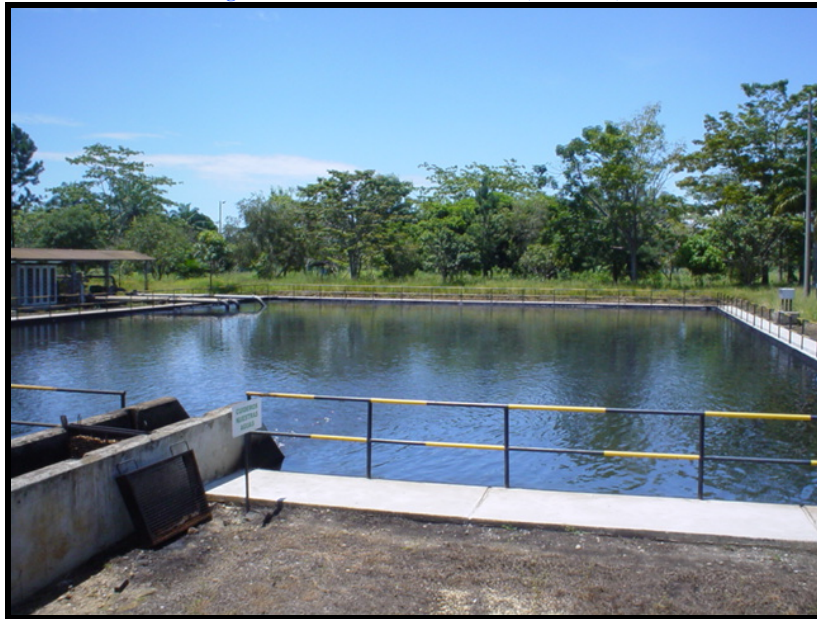
Figura 51. Piscina de estabilización (E. R. CH.)
