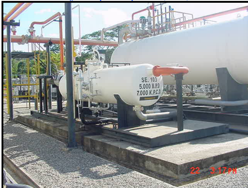
Figura 15. Separador de prueba 103 (E. R. A.)
