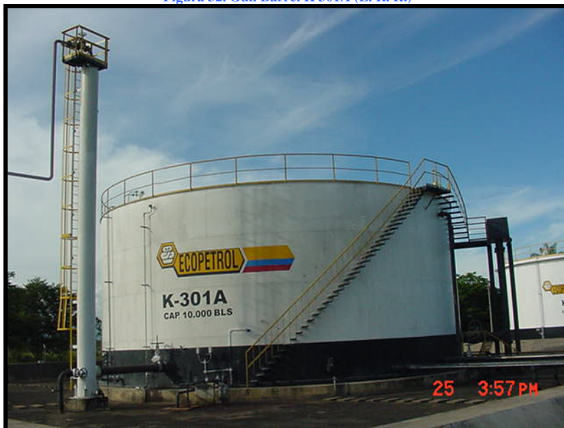
Figura 32. Gun Barrel K 301A (E. R. R.)
