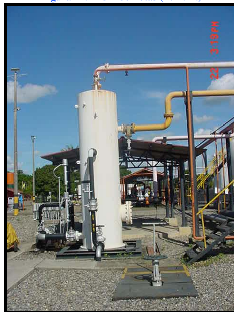
Figura 17. Drum de Botas (E. R. A.)
