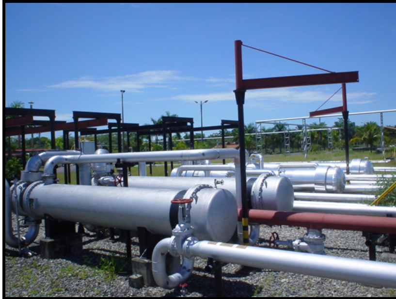
Figura 41. Pre calentadores E-101A y E-101 B (E. R. CH.)
