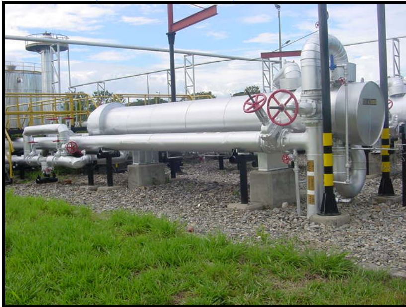
Figura 43. Calentadores E-103A y E-103 B (E. R. CH.)
