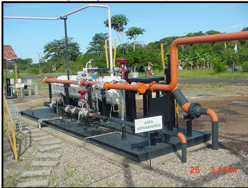
Figura 27. Separadores de Prueba 301 (E. R. R.)
