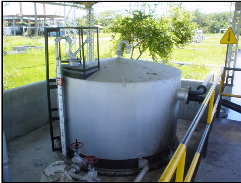
Figura 50. Sumidero (Tk – 105) (E. R. CH.)
