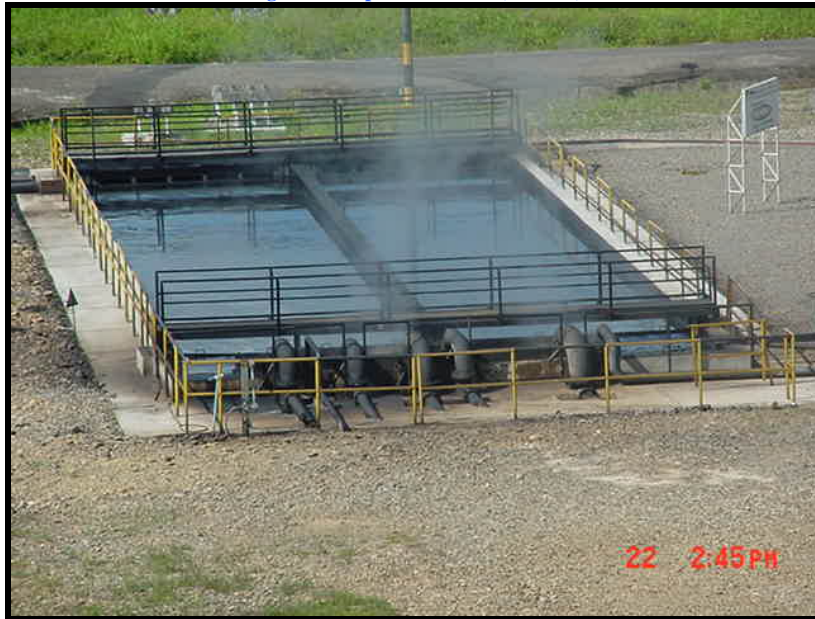
Figura 19. Separador API 2 (E. R. A.)
