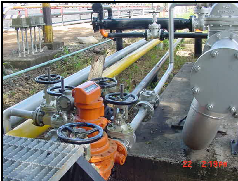
Figura 9. Contador de despacho de condensados (E. R. A.)
