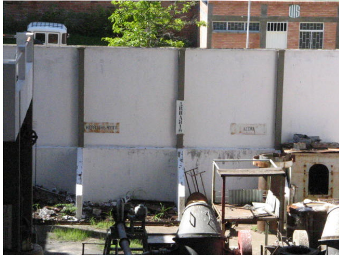
Foto 12. Aspecto de la bodega de almacenamiento de las materias primas
