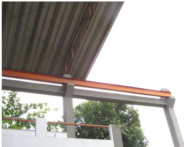
Foto 13. Aspecto del techo de la planta de aceros
