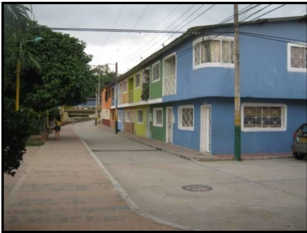
Fotografía 16. Viviendas unifamiliares 367 ubicadas en la Urbanización San Jorge II
