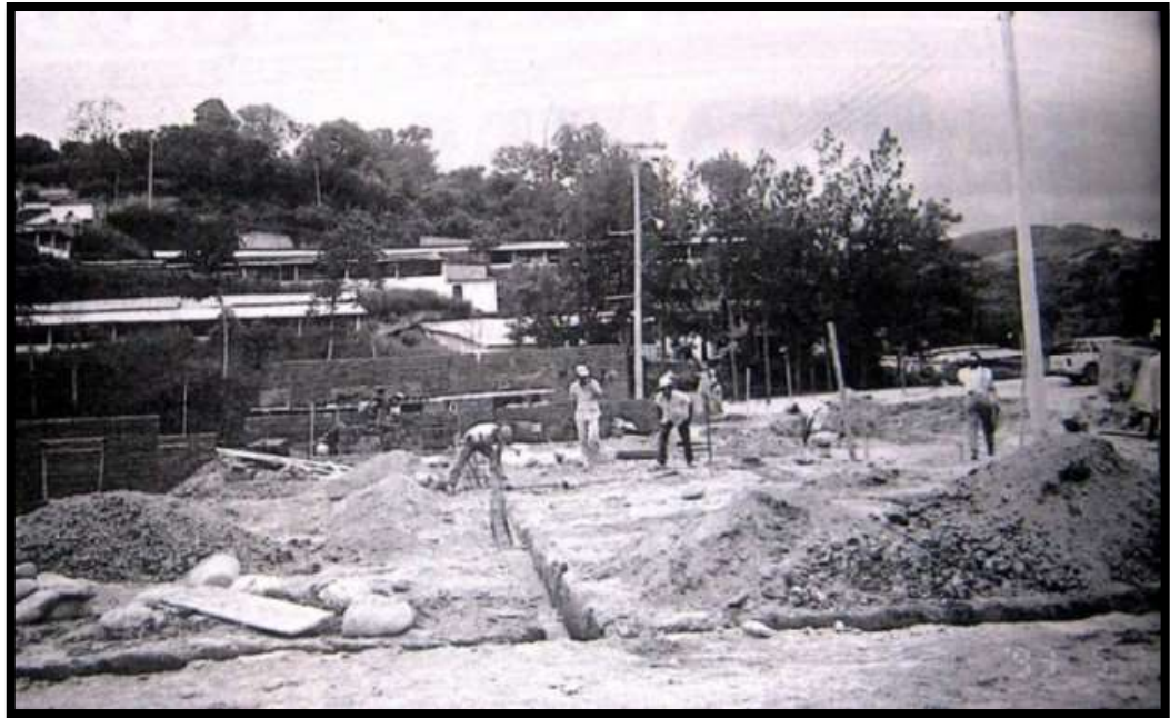
Fotografía 27. Labores de autoconstrucción en la Urbanización La Popa.
