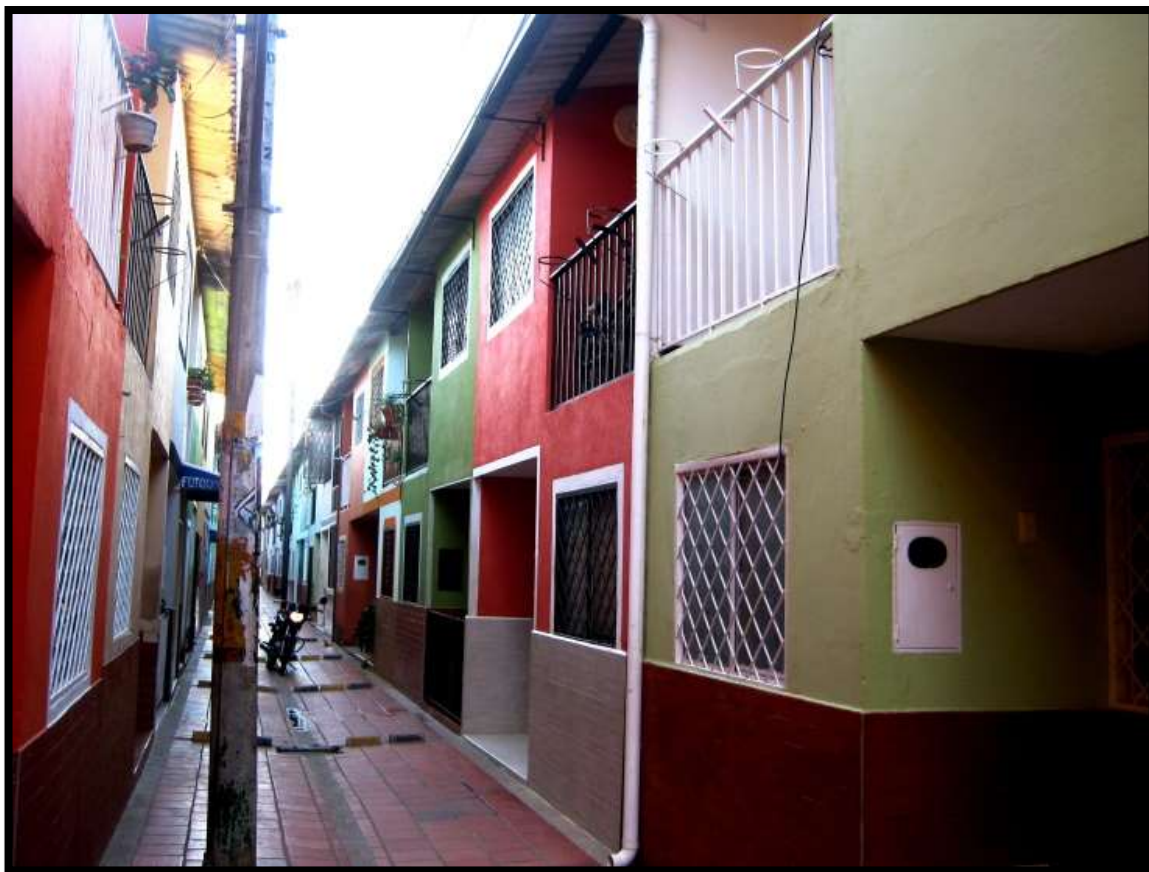
Fotografía 11. Aspecto de las casas ubicadas en la Urbanización Campo Alegre I
