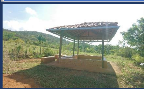
Figura 114 Infraestructura en base a la para el descanso
