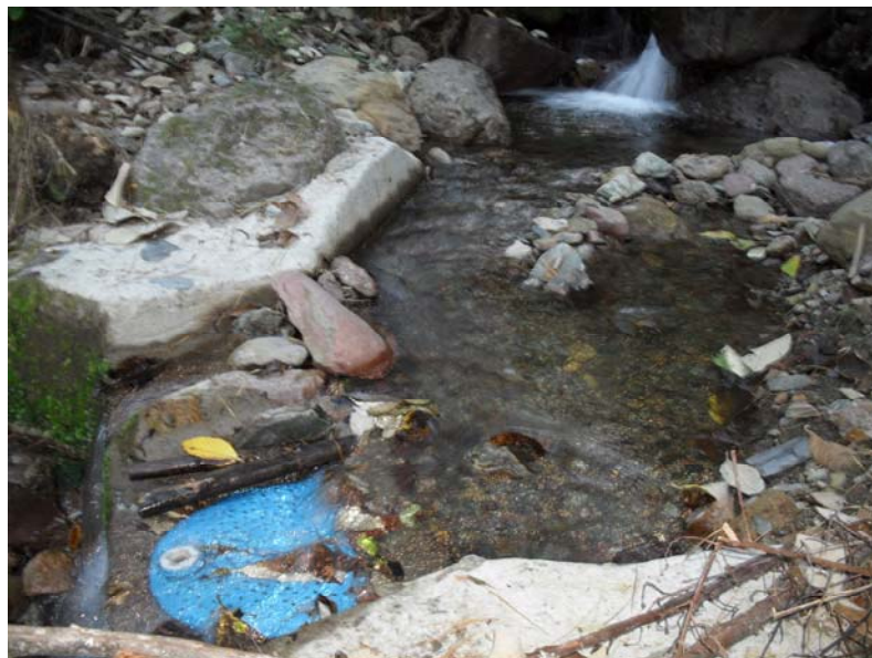
Figura 6. Punto 4, Bocatoma del acueducto.
