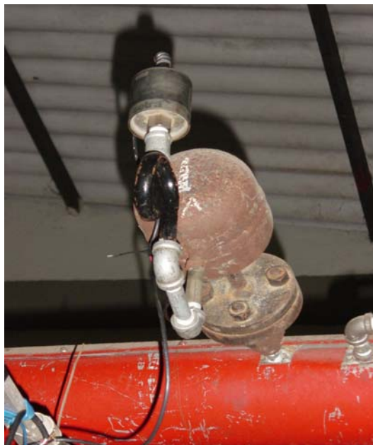
Figura 20. Sensor de Presión.
