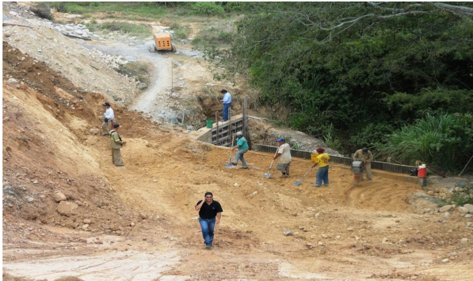
Inicio de obra, base del muro reforzado
