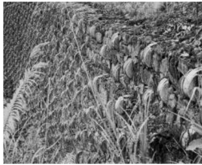
Figura 1. Suelo Reforzado con gavión reforzado en Malasia (1979)
