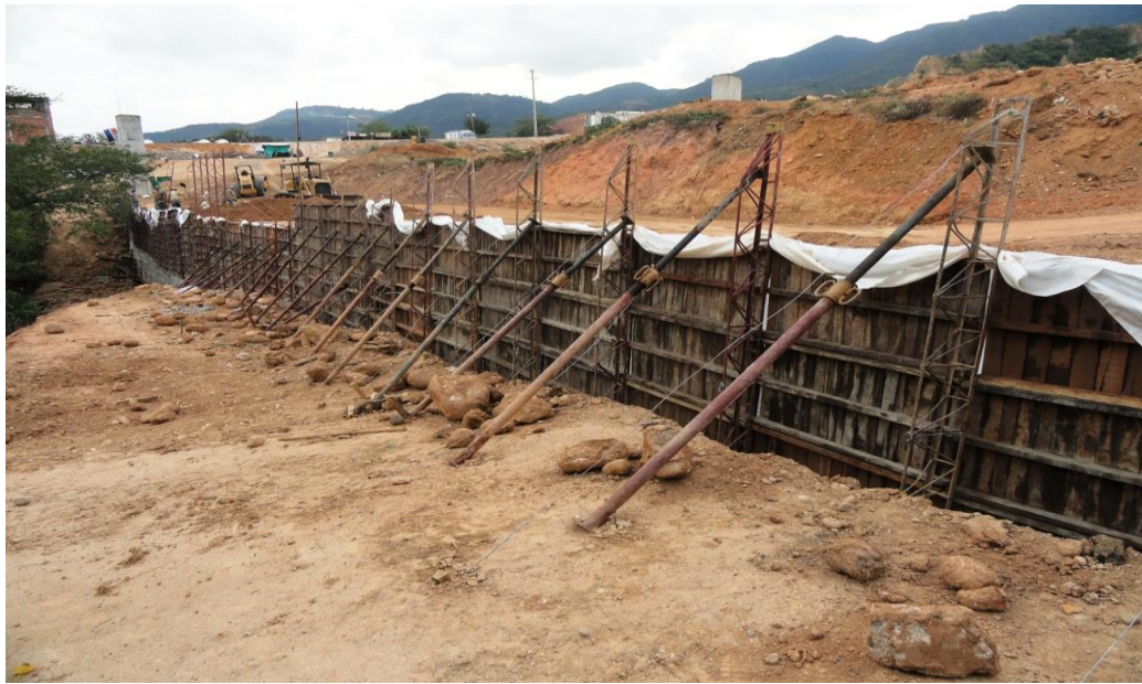
Armado formaleta Muro de Base
