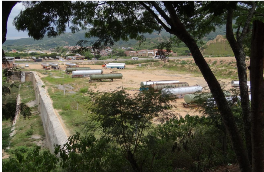
Figura 23. Terraza y muro de contención terminados
