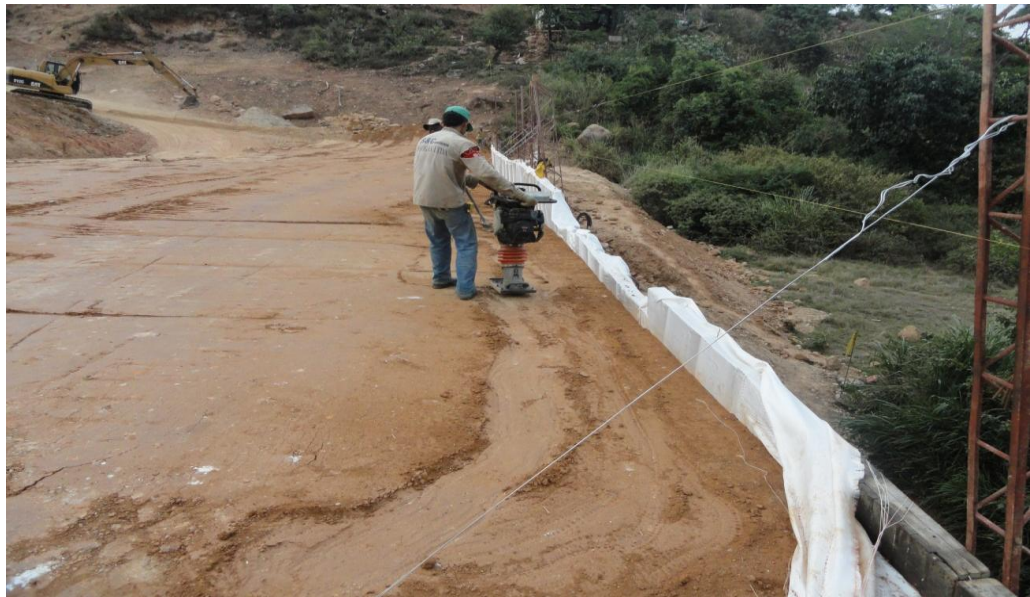
Compactación cerca a la formaleta con equipo liviano
