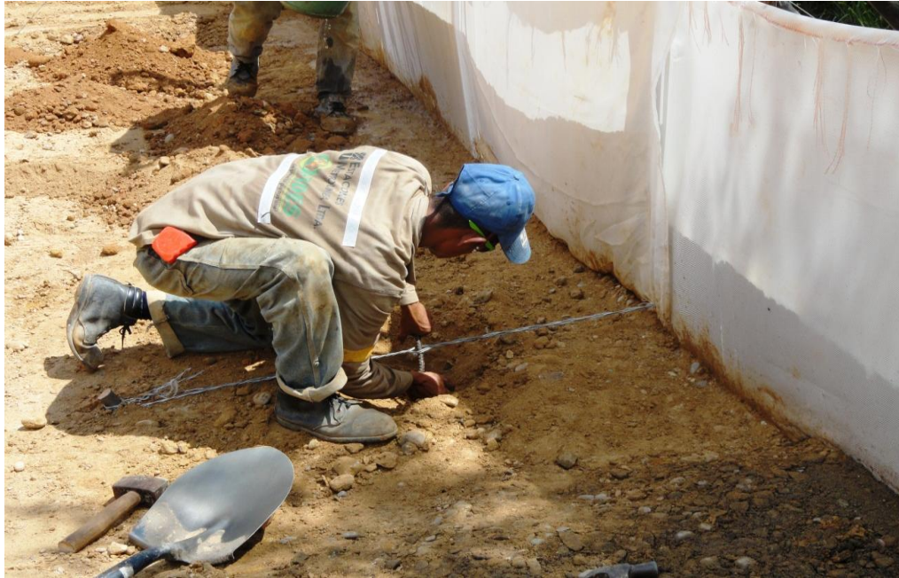
Refuerzo y atirantado de la formaleta
