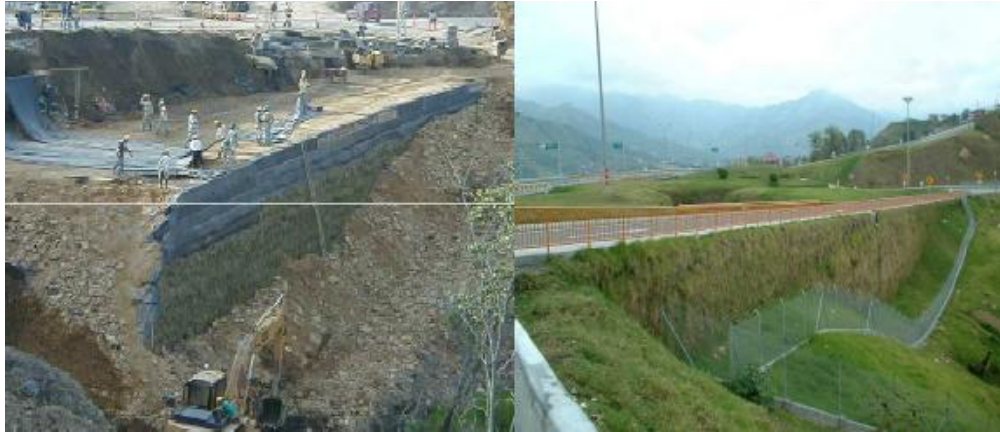
Figura 10. Muros de contención
