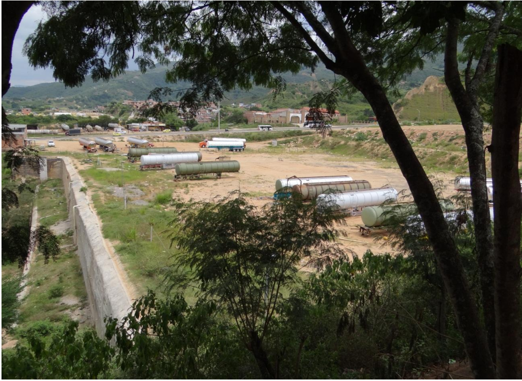
Terraza y muro de contención terminados
