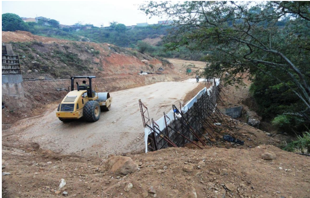
Proceso de compactación capa a capa
