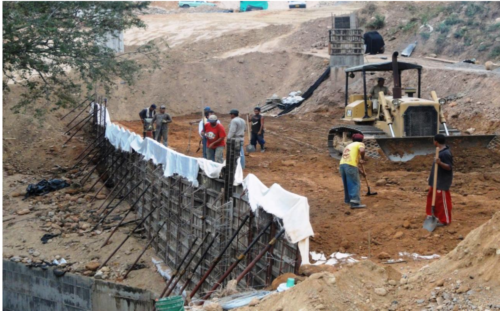
Colocación de capas de material
