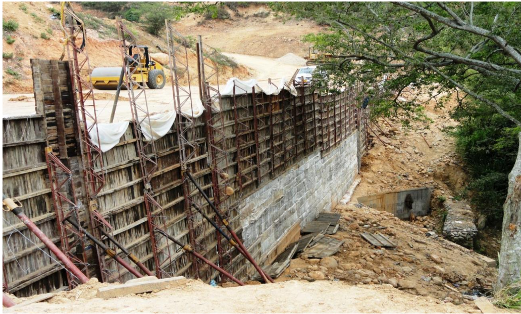
Desformateado Muro de Base
