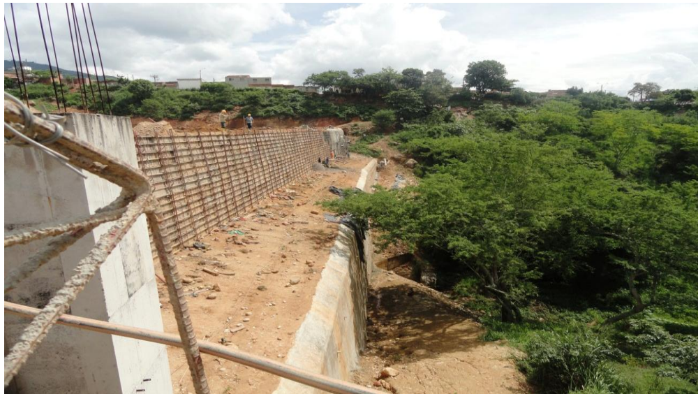
Construcción muro superior
