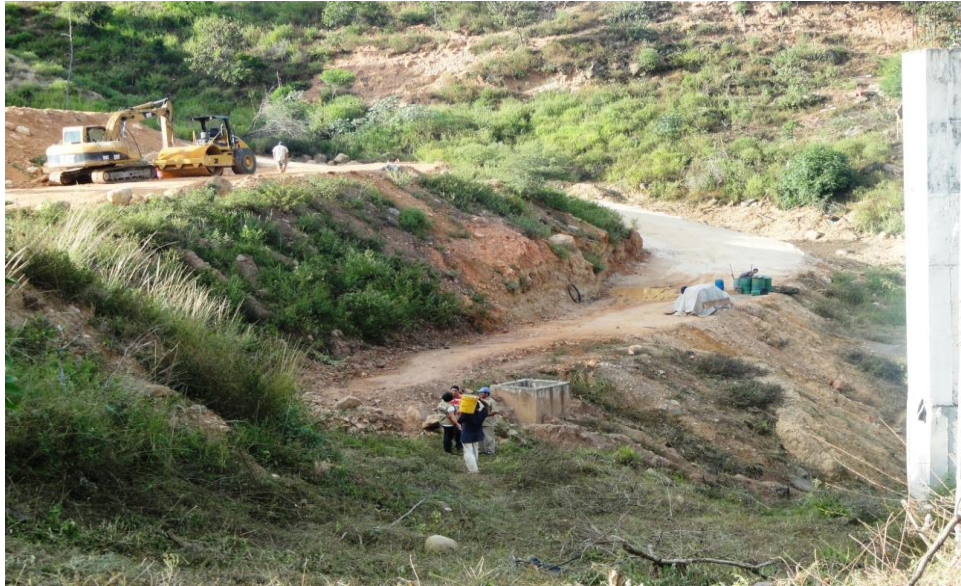
Inicio de obra, condiciones iniciales de construcción
