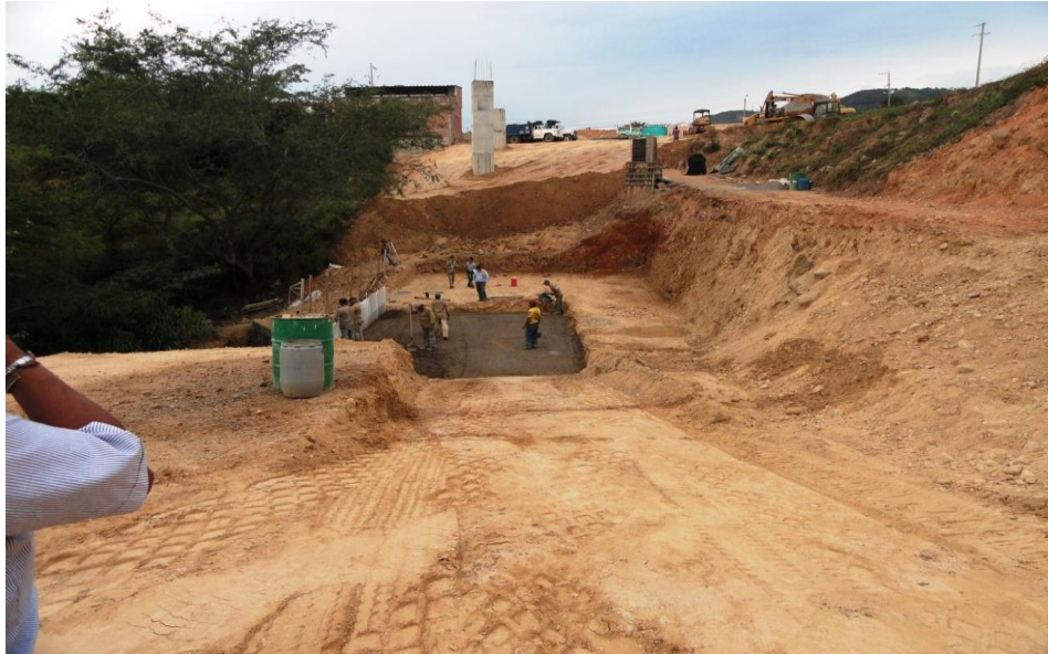
Primeras capas del muro reforzado
