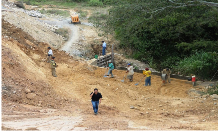
Figura 22. Inicio de obra, base del reforzado
