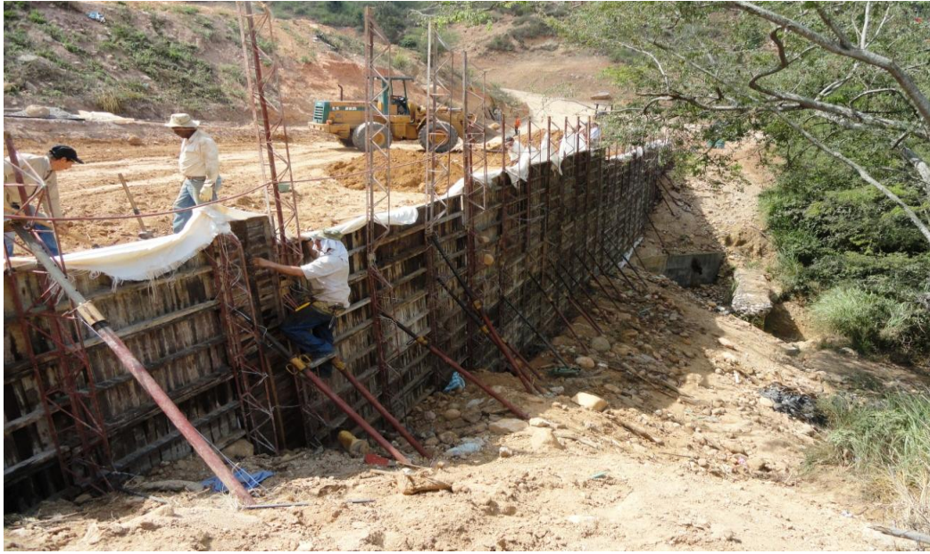
Armado formaleta Muro de Base
