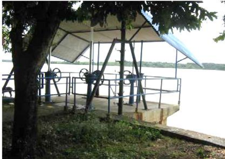
Figura 4. Sistema de Captación Lateral
