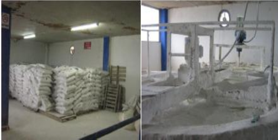
Figura 17. Almacenamiento y dosificación de cal.
