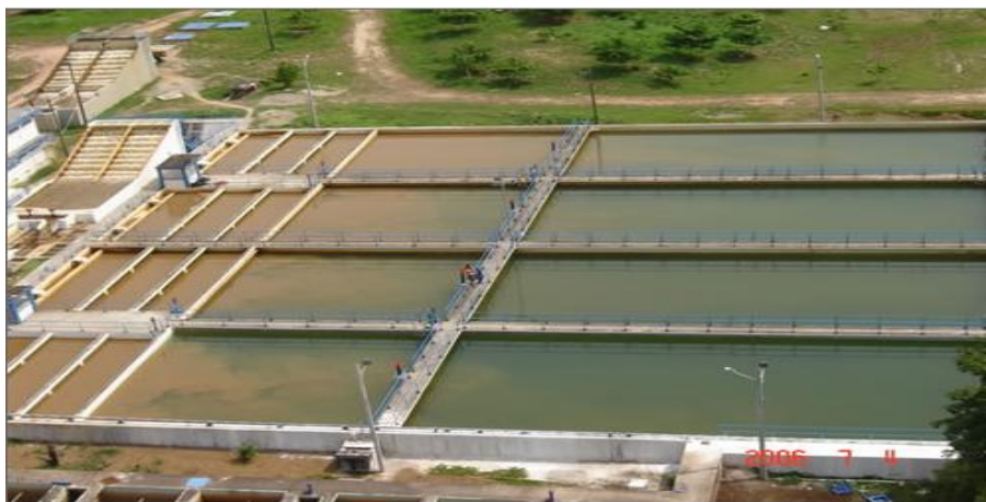
Figura 24. Sedimentadores
