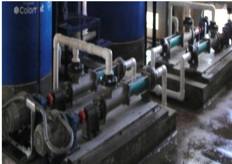
Figura 19. Bombas dosificadoras Pre oxidante y Polímero
