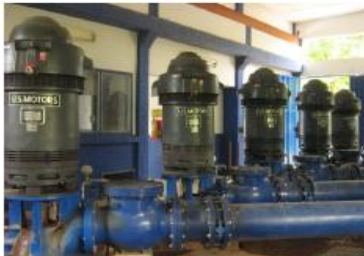
Figura 7. Bombas Bocatoma
