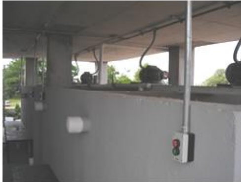
Figura 12. Tanques de dilución sulfato de aluminio
