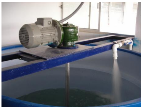
Figura 20. Sistema de agitación Tanques de dosificación Pre oxidante y Polímero
