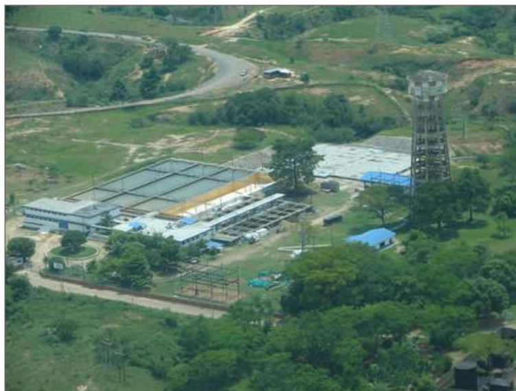
Figura 1. Vista Panorámica Planta de Tratamiento
