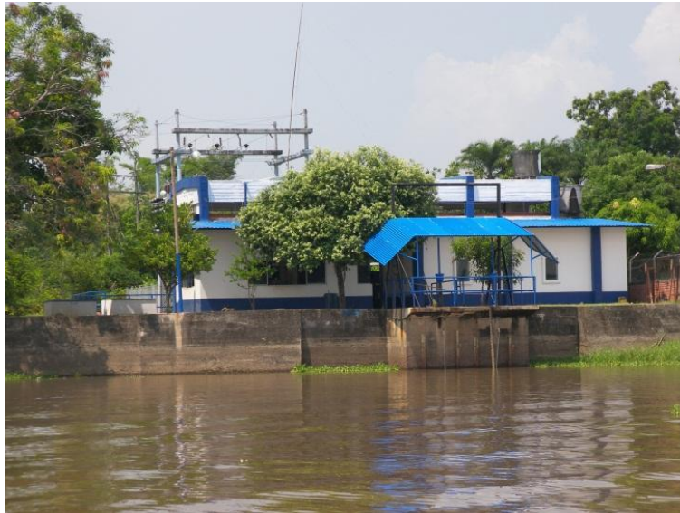
Figura 9. Casa estación de bombeo
