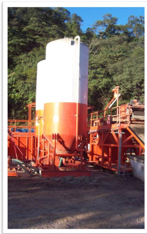
Figura 9. Tanque de almacenamiento
