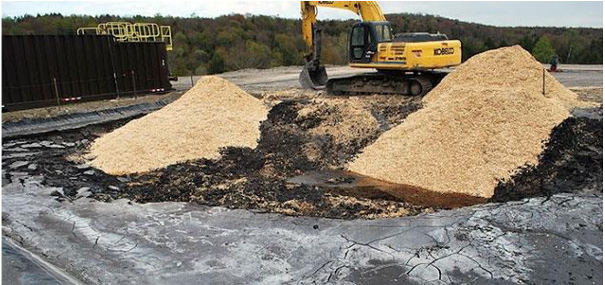
Figura 4. Desechos de perforación removidos de piscinas
